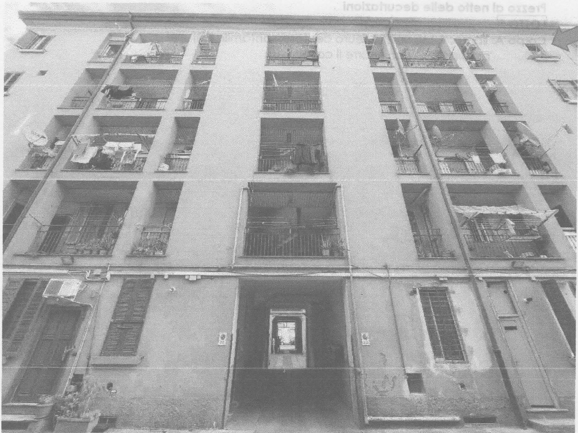
LOTTO 1 >>>>abitazione + cantina + solaio
