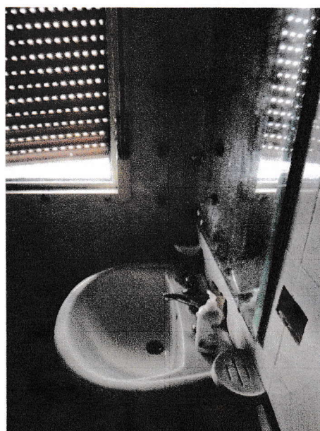
Foto 16: vano wc vista dall'interno
