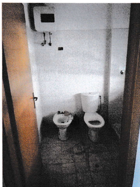
Foto 15: vano wc vista dal corridoio
