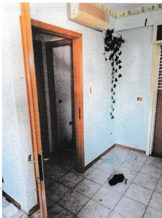
Foto 13: vano cucina/ingresso dis
