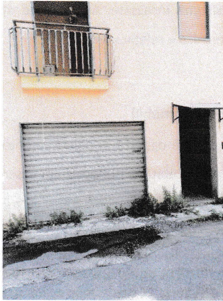
Foto 26: prospetto via della Vittoria
