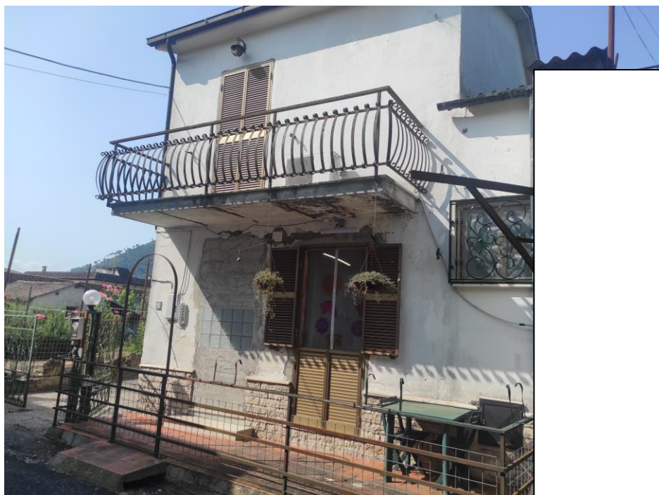
Vista esterna del fabbricato. (Prospetto lato nord-est)
