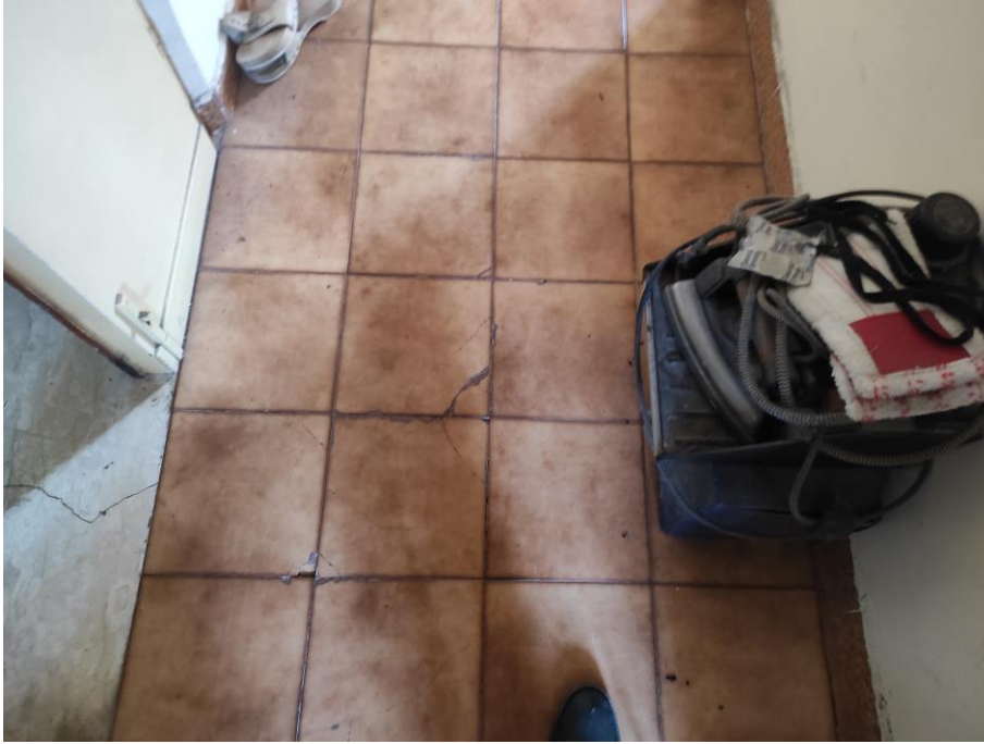
Vista parziale interna del disimpegno a piano primo in cui si evincono le rifiniture.
