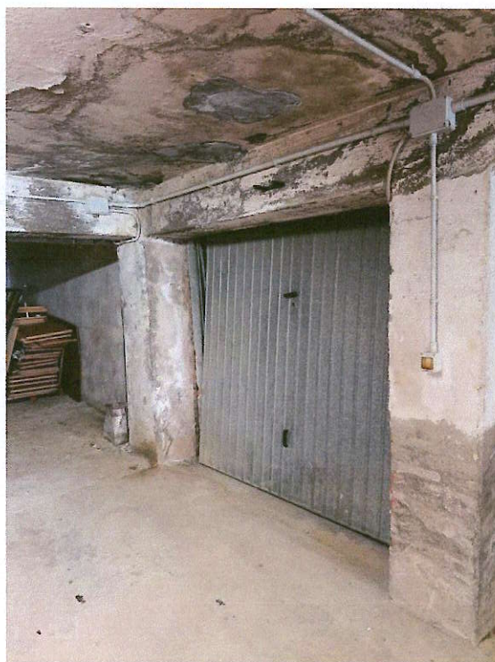
Foto garage Piano Primo Sottostrada
