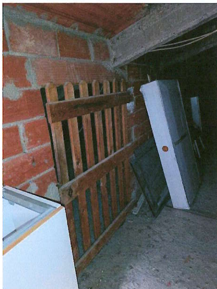
Foto accesso alla soffitta del Piano Terzo
