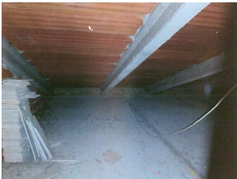
Foto Soffitta Piano Terzo
