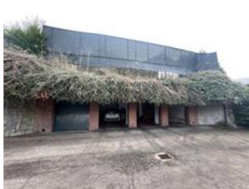
vista esterna dell'immobile
