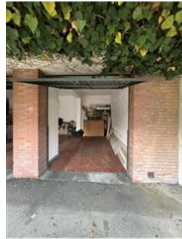
particolare di entrata ad una delle campate
