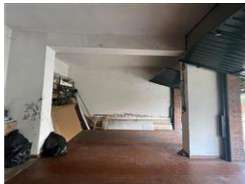
vista dell'interno dell'immobile verso la parete sud
