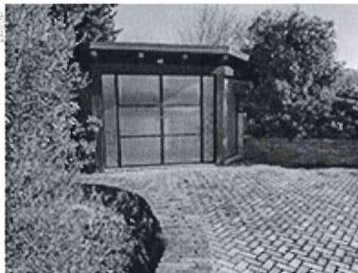
foto 2: il secondo volume da demolire
