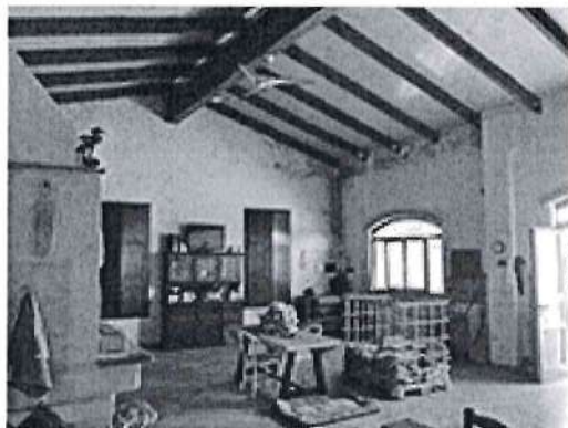
foto 7: interno del sub 6
