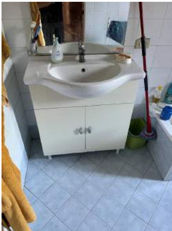
Fotografia 15- Vista del locale bagno
