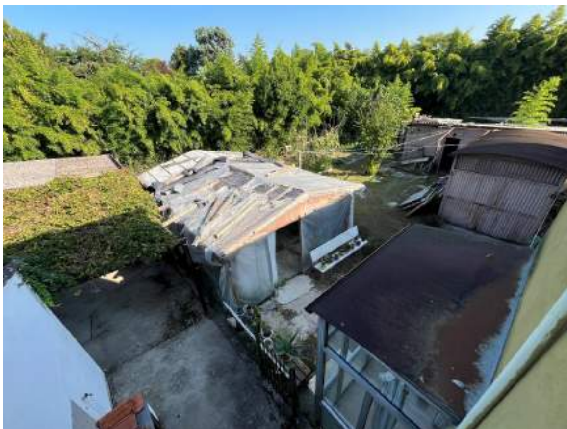
Fotografia 6– Vista dal cortile sul retro
