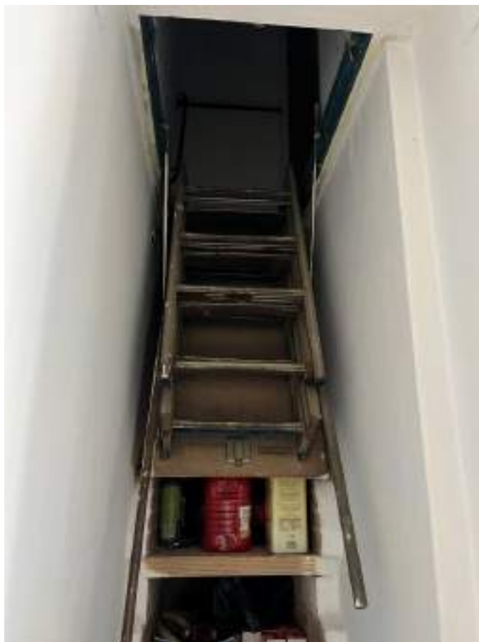
Fotografia 16 – Vista scala retrattile accesso piano primo dal disimpegno piano terra
