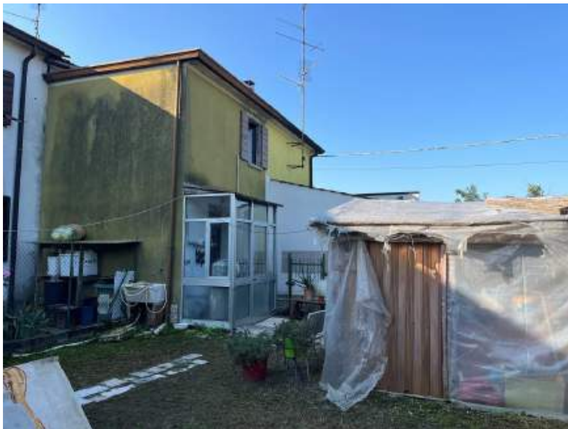
Fotografia 7 – Vista dell'immobile dal giardino sul retro
