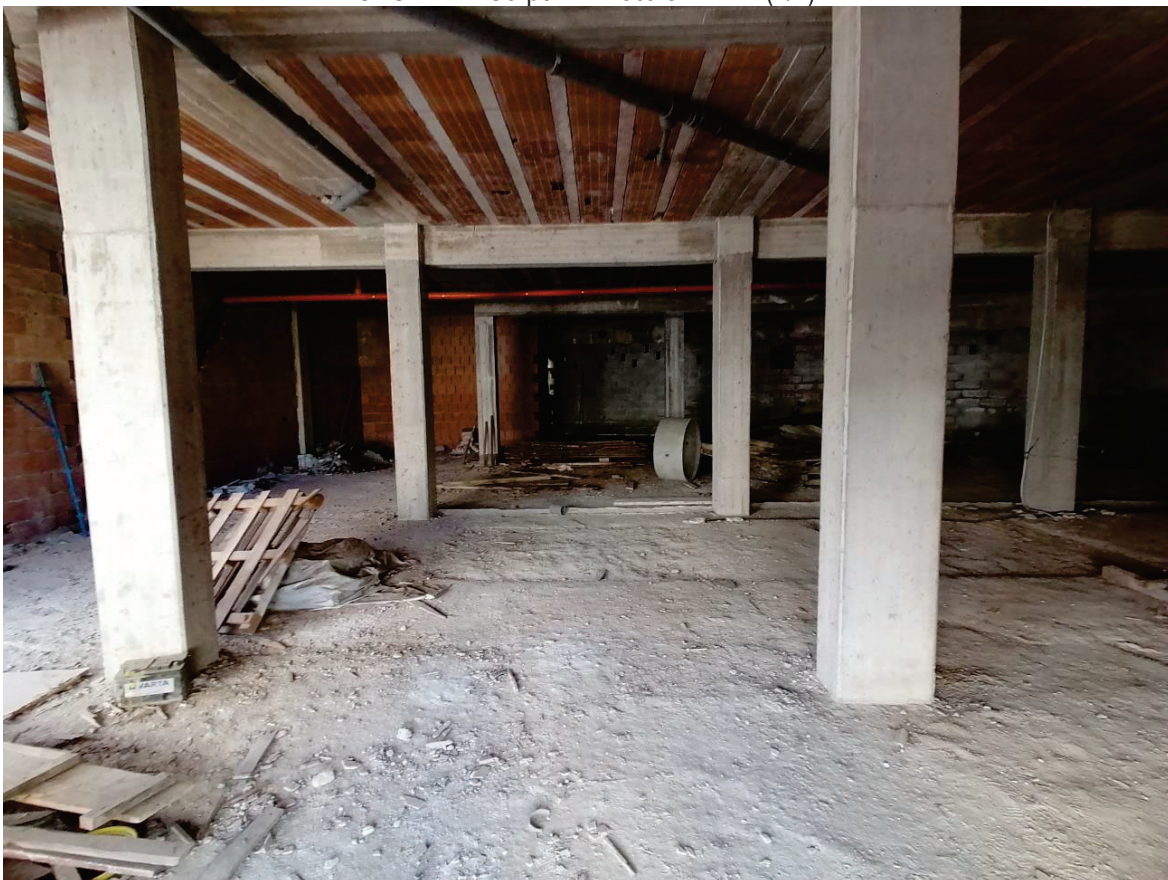
FOTO N°41: Corpo H – Locale 1 – PT (1/2).
