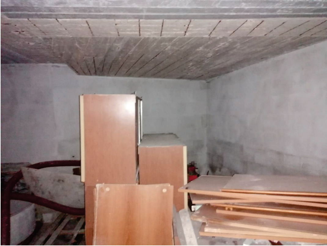
FOTO N°31: Corpo D – Garage – Piano Sottostrada (2/2).
