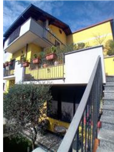
Scala esterna di accesso all'unità immobiliare oggetto di perizia e giardino comune
