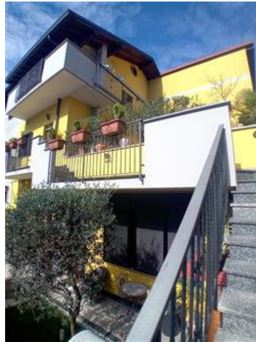
Foto scala esterna di accesso all'unità immobiliare in perizia posta al Piano Primo dell'edificio bifamiliare con accesso dal cortile comune - difforme alla DIA n. 119/2006 ultimo titolo edilizio
