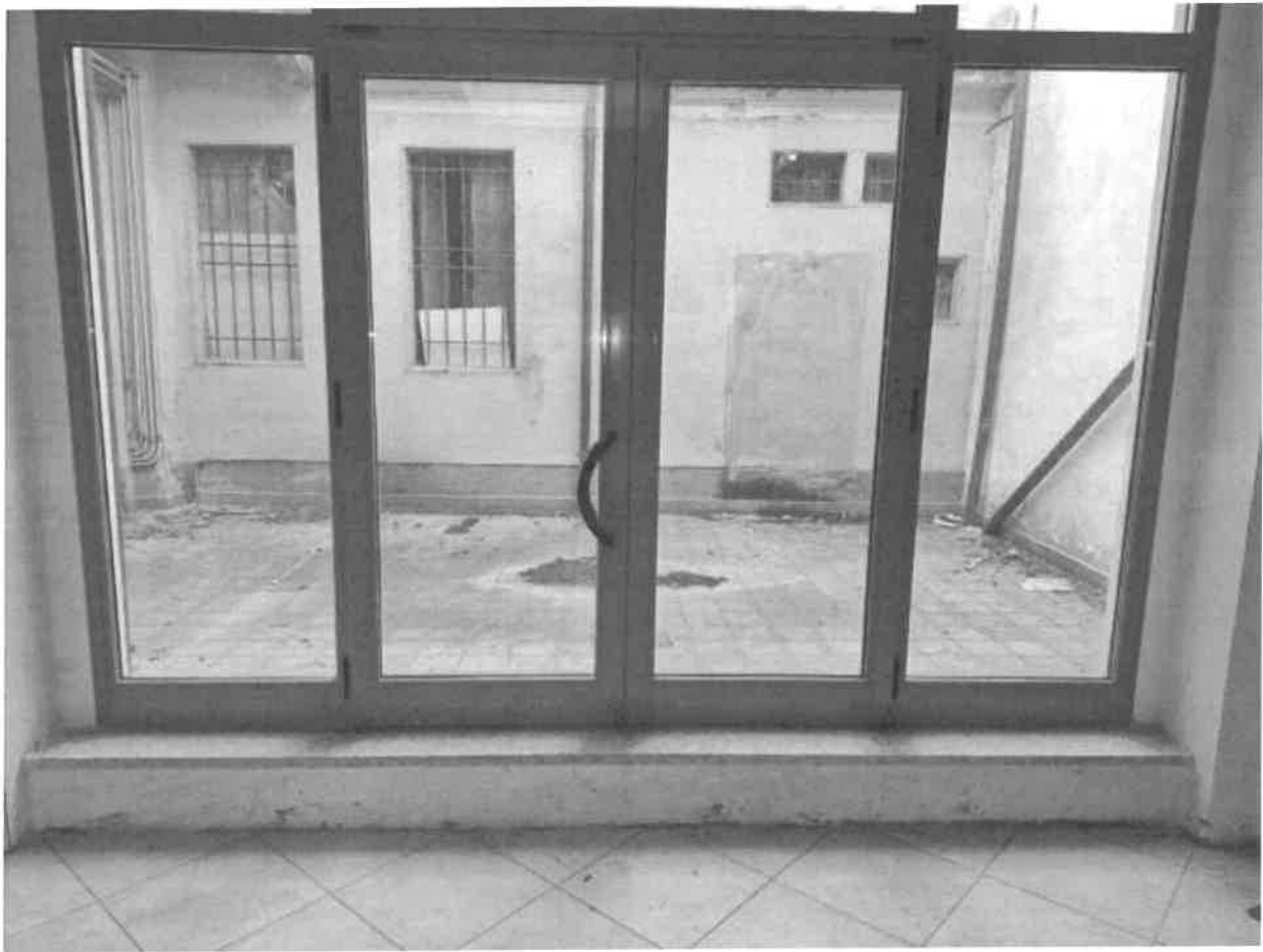
FOTO 5 – Vetrata di accesso al cortile interno
