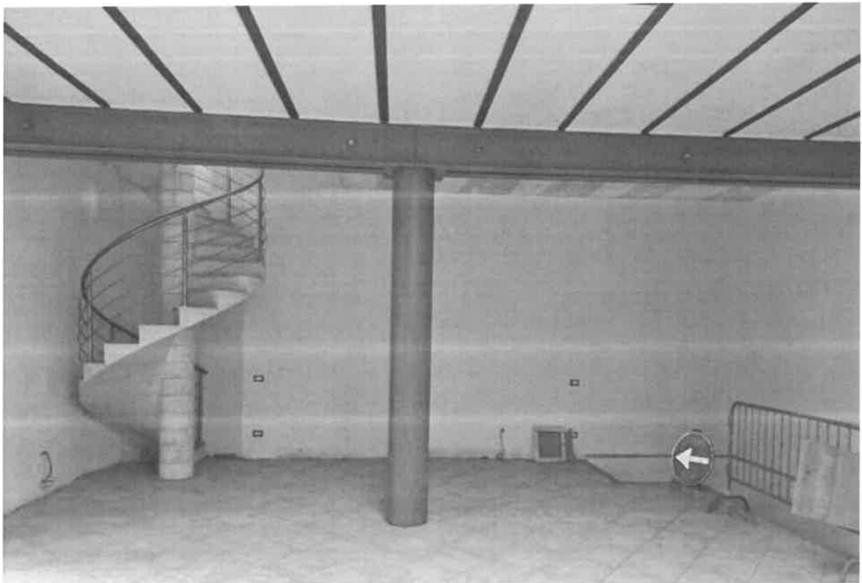
FOTO 6 – Particolare locale con vista scala di accesso al piano interrato e chiocciola di accesso al piano primo
