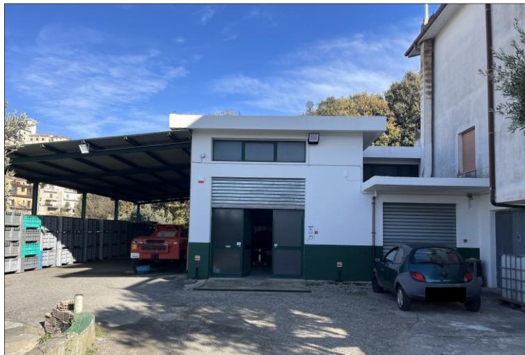
Fig. 9– FOTO FABBRICATO – PIANO TERRA
