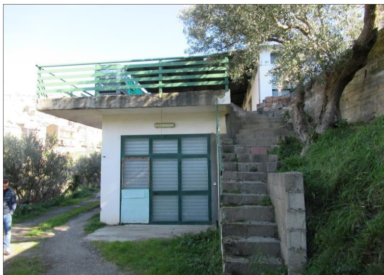
Fig. 10– FOTO FABBRICATO –Collegamento dal piano terra al piano seminterrato a mezzo scala esterna
