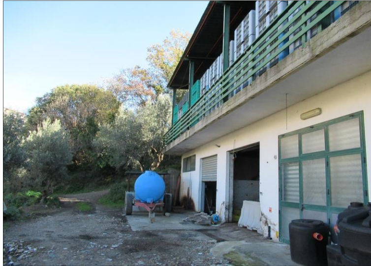
Fig. 11 – FOTO FABBRICATO – Piano seminterrato
