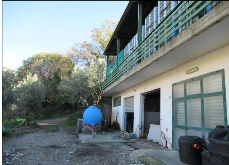
Fig. 11 – FOTO FABBRICATO – Piano seminterrato
