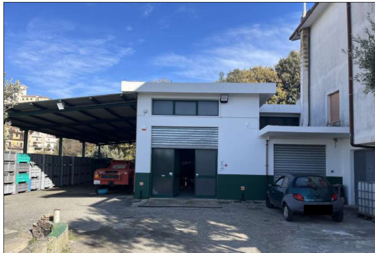
Fig. 9– FOTO FABBRICATO – PIANO TERRA
