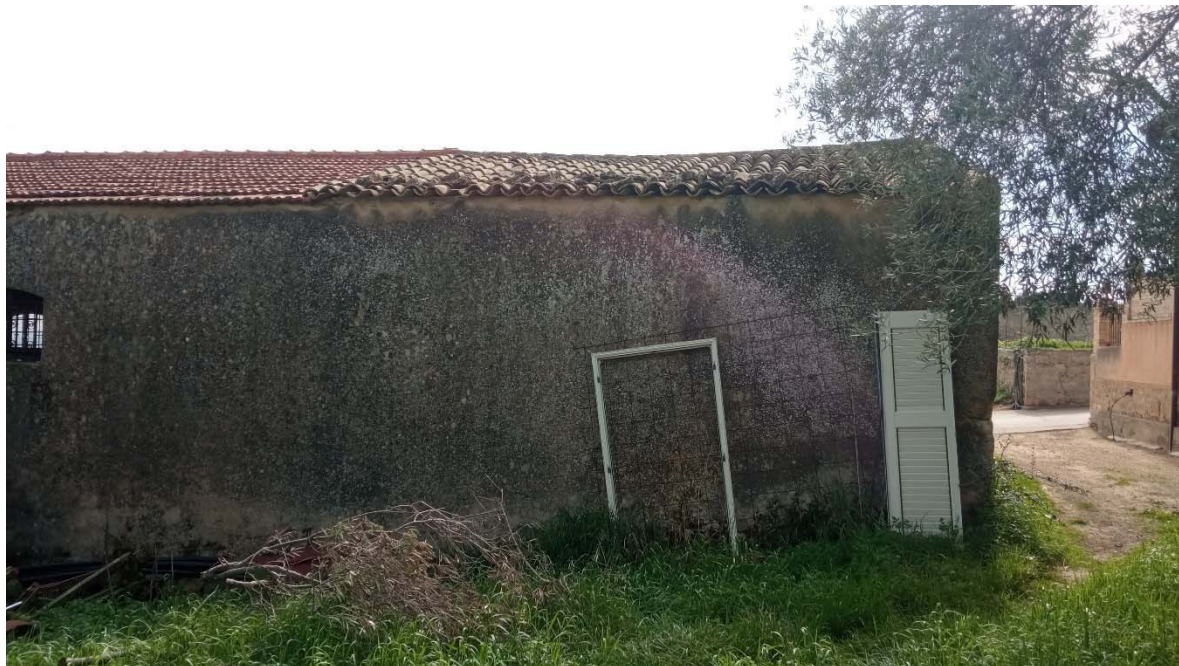
Foto n. 7 vista del fabbricato, prospetto Nord, sito nel terreno identificato con la particella 48
