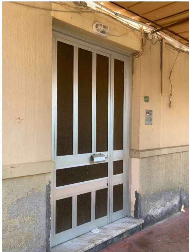
Foto n. 7 - Portone d'ingresso all'edificio
