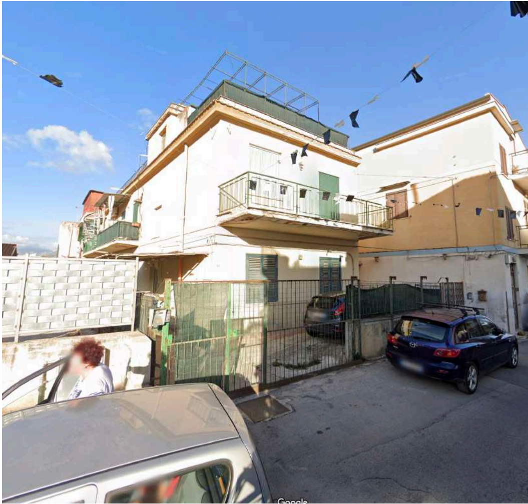
Foto n. 2 - Prospetto su via Aloi
