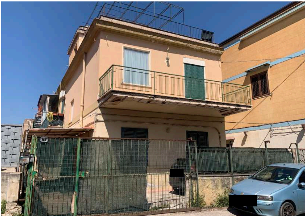
Foto n. 3 - Prospetto su via Aloi
