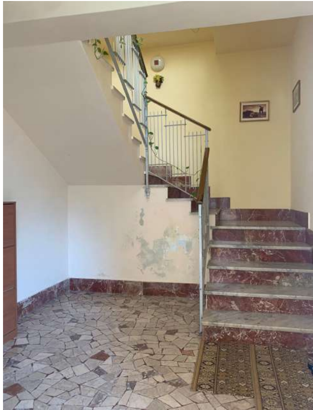
Foto n. 8 - Androne e corpo scala condominiali
