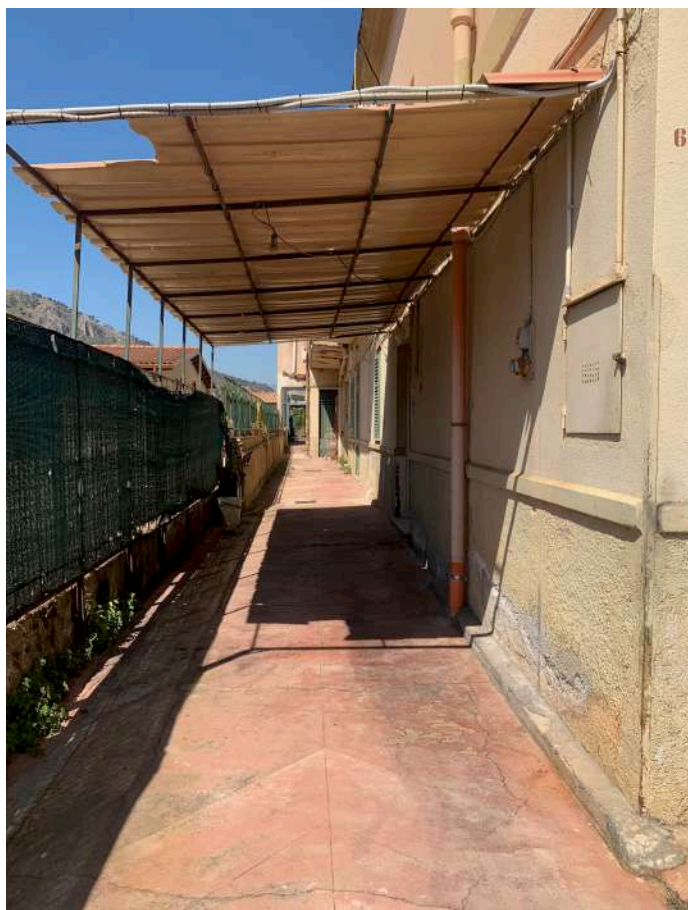
Foto n. 4 - Prospetto laterale verso l'ingresso
