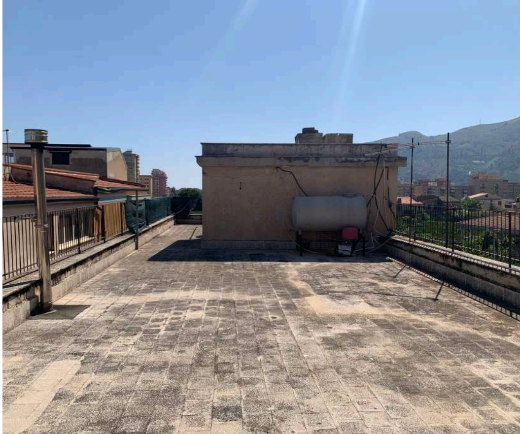
Foto n. 25 - Lastrico solare di copertura e torrino scala
