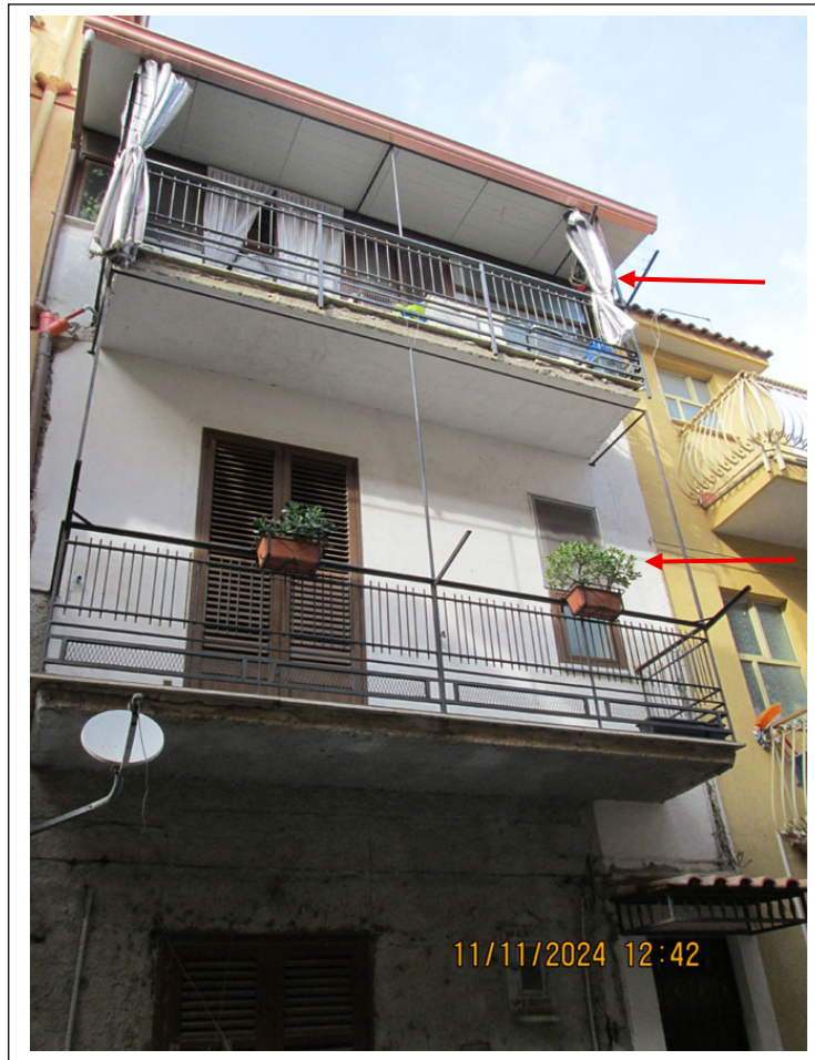
Foto n. 2. Prospetto su via Vittorio Veneto. Con le frecce sono indicati i balconi del primo e secondo piano
