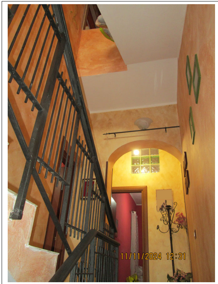
Foto n. 5. Scala del fabbricato che conduce all'immobile del primo piano
