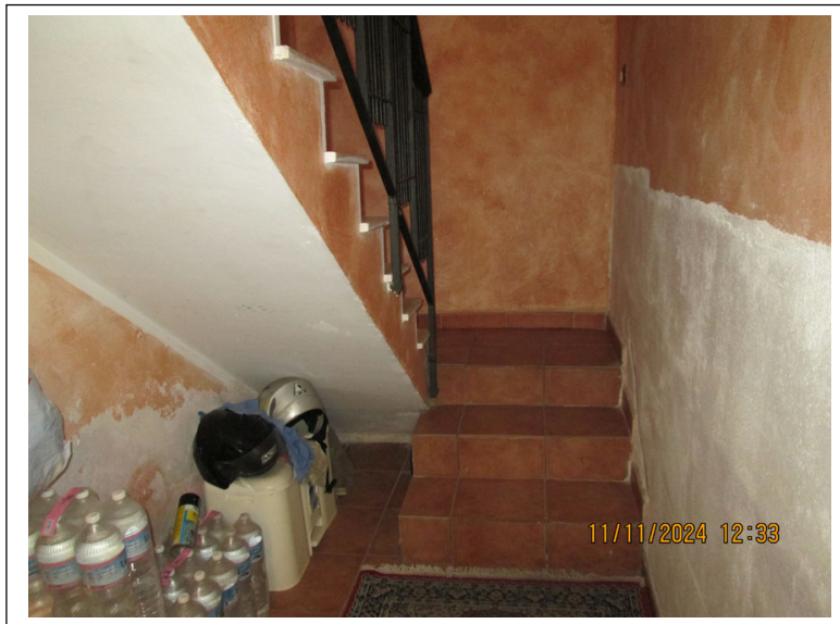
Foto n. 3-4. Scala di ingresso al piano terra
