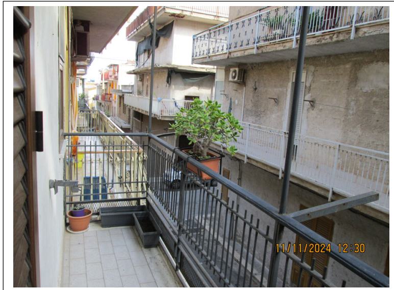
Foto n. 14-15. Balcone del primo piano che prospetta su via Vittorio Veneto
