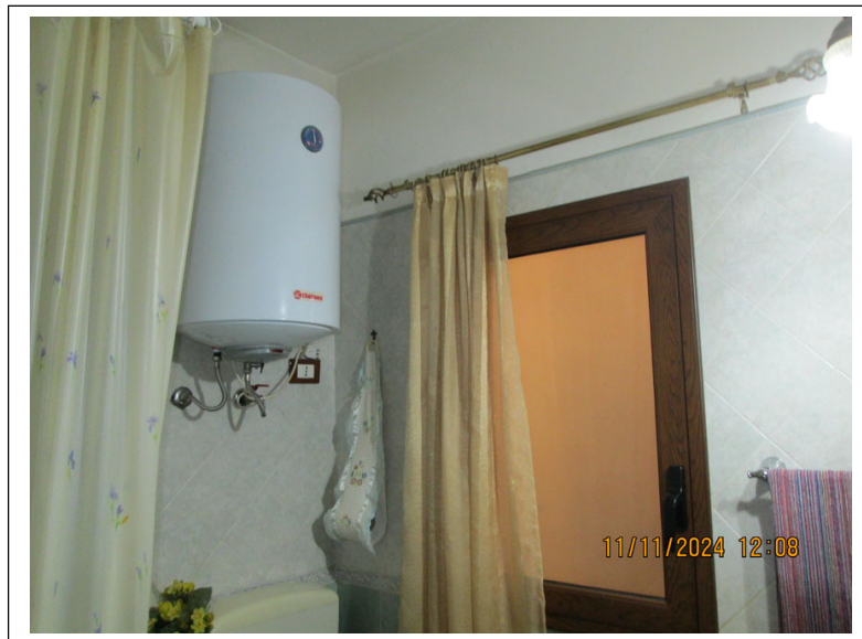
Foto n. 25-26. Servizio igienico con doccia
