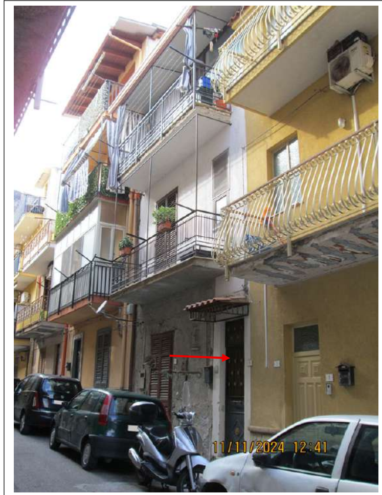
Foto n. 1. Prospetto su via Vittorio Veneto. Con la freccia è indicato l'ingresso agli immobili dal civico n. 5
