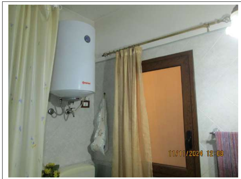
Foto n. 25-26. Servizio igienico con doccia
