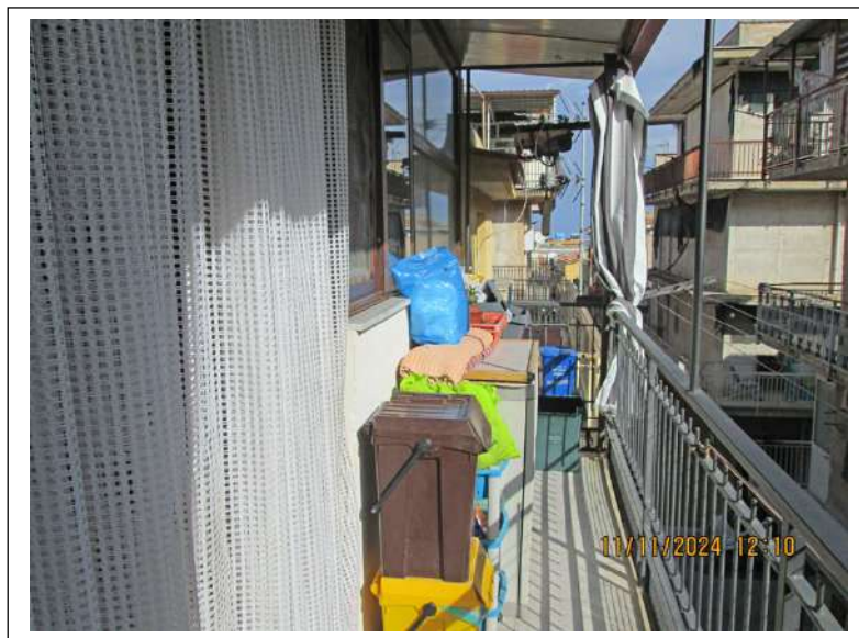
Foto n. 27-28. Balcone del secondo piano che prospetta su via Vittorio Veneto
