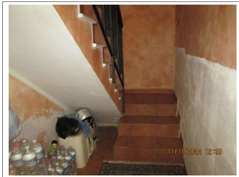
Foto n. 3-4. Scala di ingresso al piano terra
