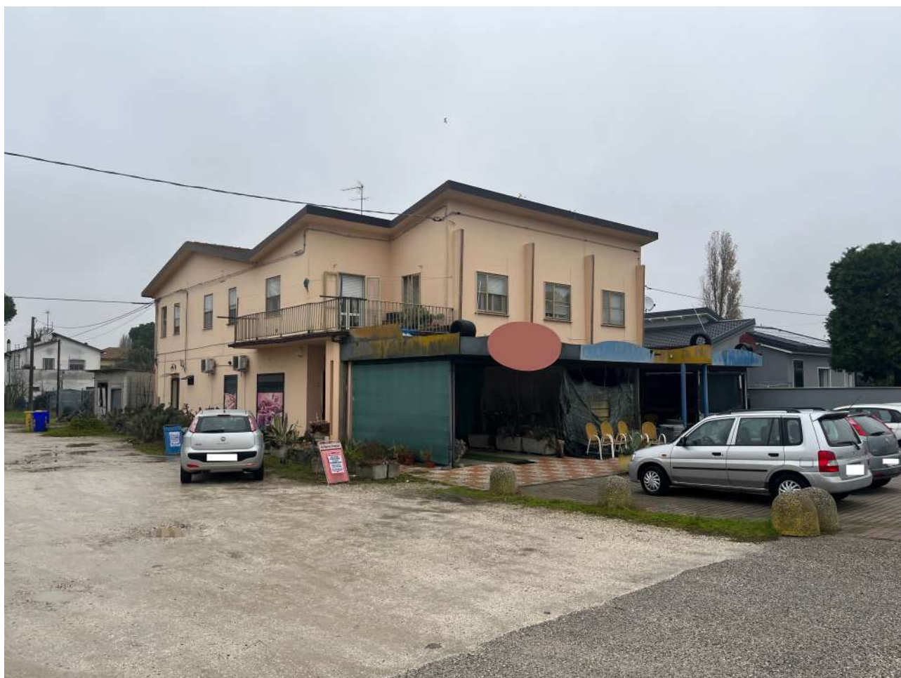
Prospetto laterale dello stabile
