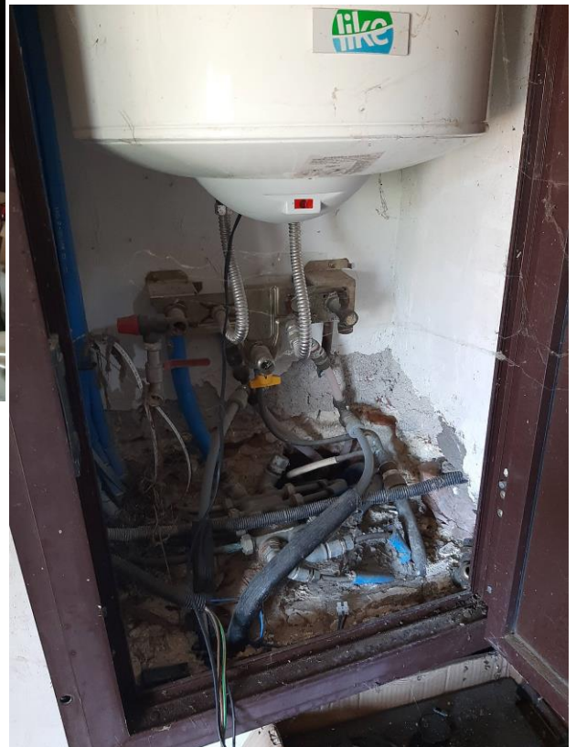
Vano ex alloggio caldaia, oggi occupato da scaldabagno elettrico
