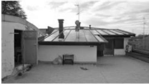
terrazzo con accesso al sottotetto del sub. 10
