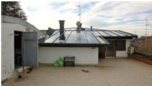
terrazzo con accesso al sottotetto del sub. 10
