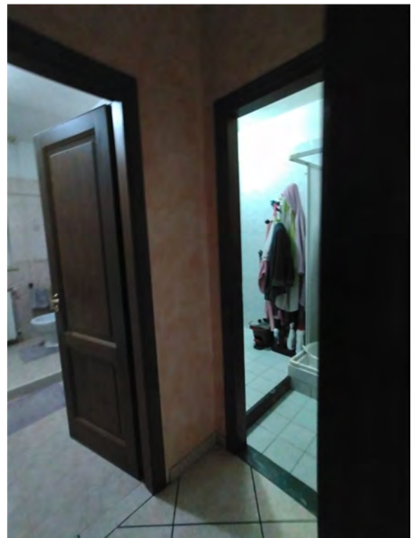
FOTO 28- BAGNO 1E 2, VISTA DA DISIMPEGNO
