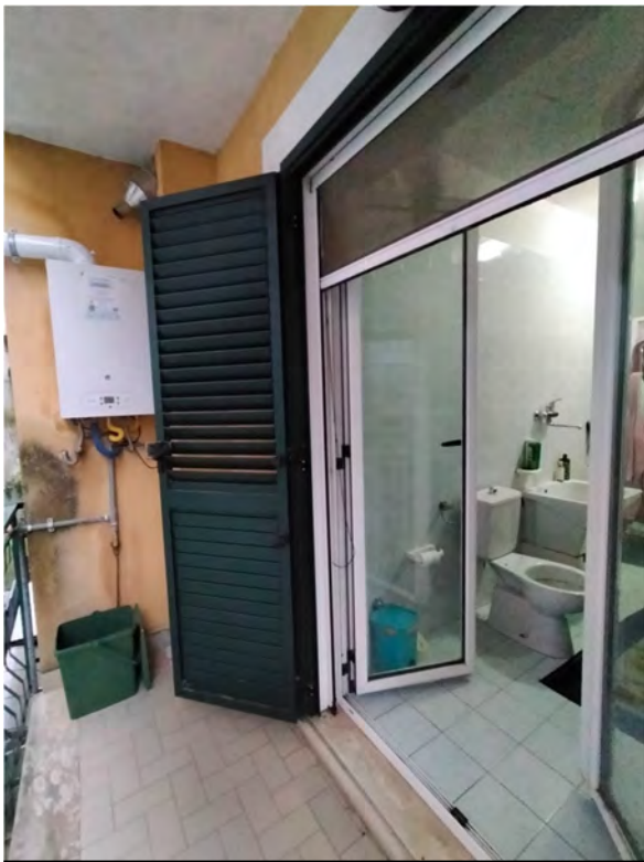
FOTO 31- BALCONE CON ACCESSO DAL BAGNO 2
