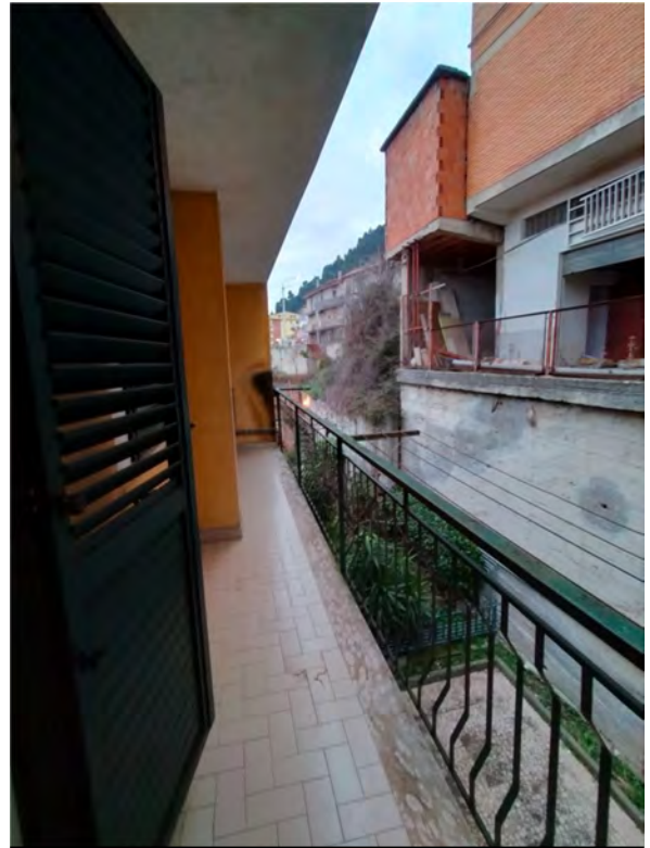
FOTO 32- BALCONE CON ACCESSO DAL BAGNO 2
