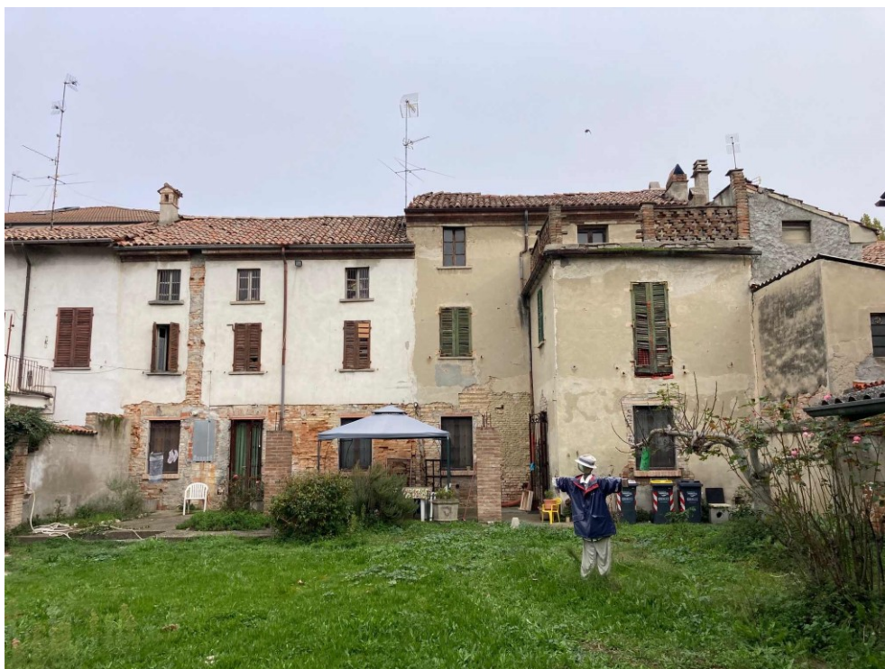
Foto 2 – Prospetto abitazione dal cortile
