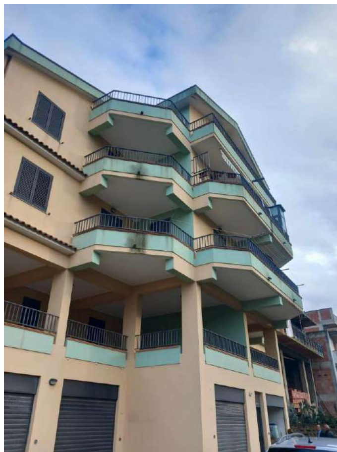
Foto 3...5 “Particolare del fabbricato dal fronte opposto via Roma”
