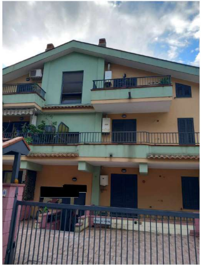
Foto 1 e 2 "Particolare del fabbricato da via Roma"
