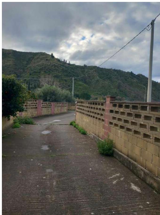
Foto 7 “Particolare dell’accesso carrabile e pedonale e delle aree condominiali dal fronte opposto via Roma”
