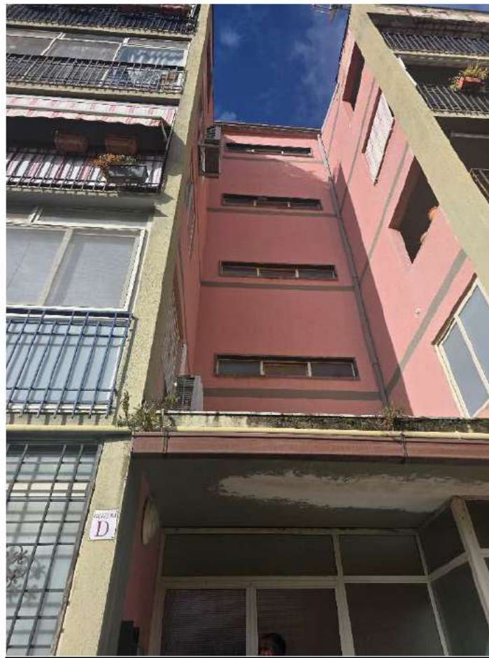
FOTO 2 – VISTA INGRESSO PALAZZINA D
