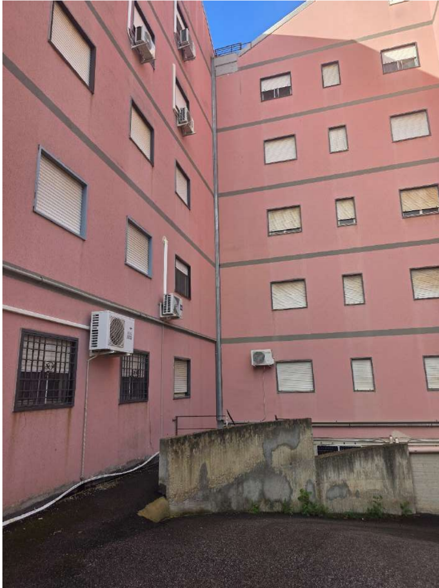
FOTO 3 – VISTA LATERALE PALAZZINA D
