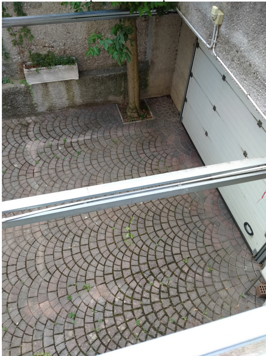
FOTO 37 – area esterna; portone sezionale per l'accesso da via Romagna
