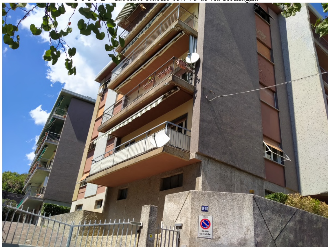
FOTO 2 – facciate stabile civ. 78 di via Romagna
