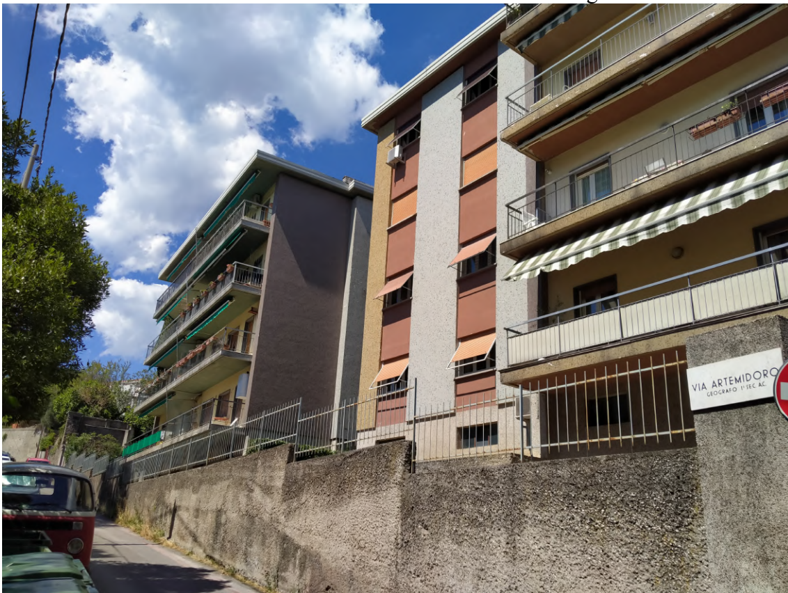
FOTO 3 – facciate stabile civ. 78 di via Romagna
