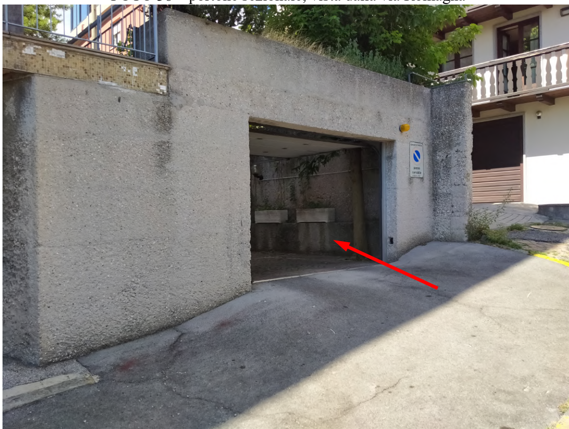
FOTO 38 – portone sezionale; vista dalla via Romagna
