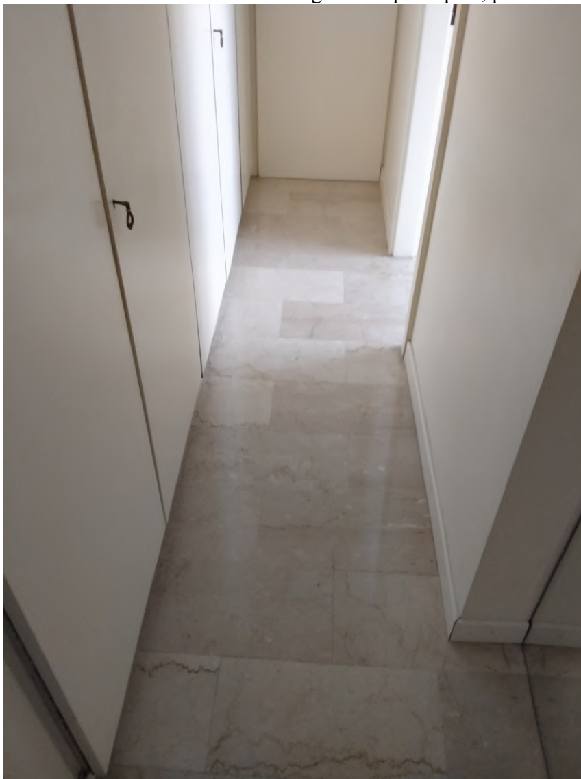
FOTO 16 – tratto corridoio verso camera da letto e bagno-w.c. principale; pavimento in lastre di marmo
