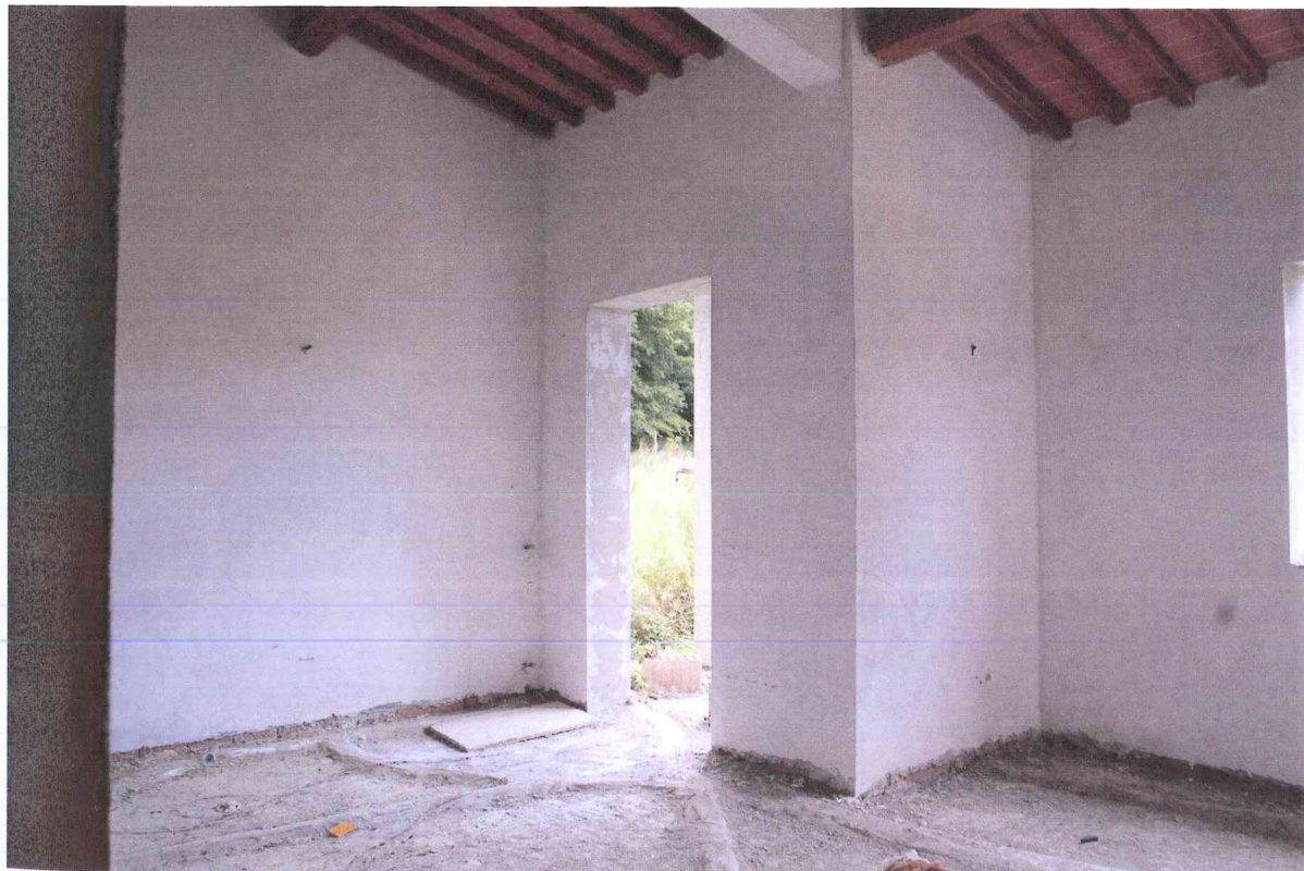
Foto n. 12 Il fabbricato D – interni
