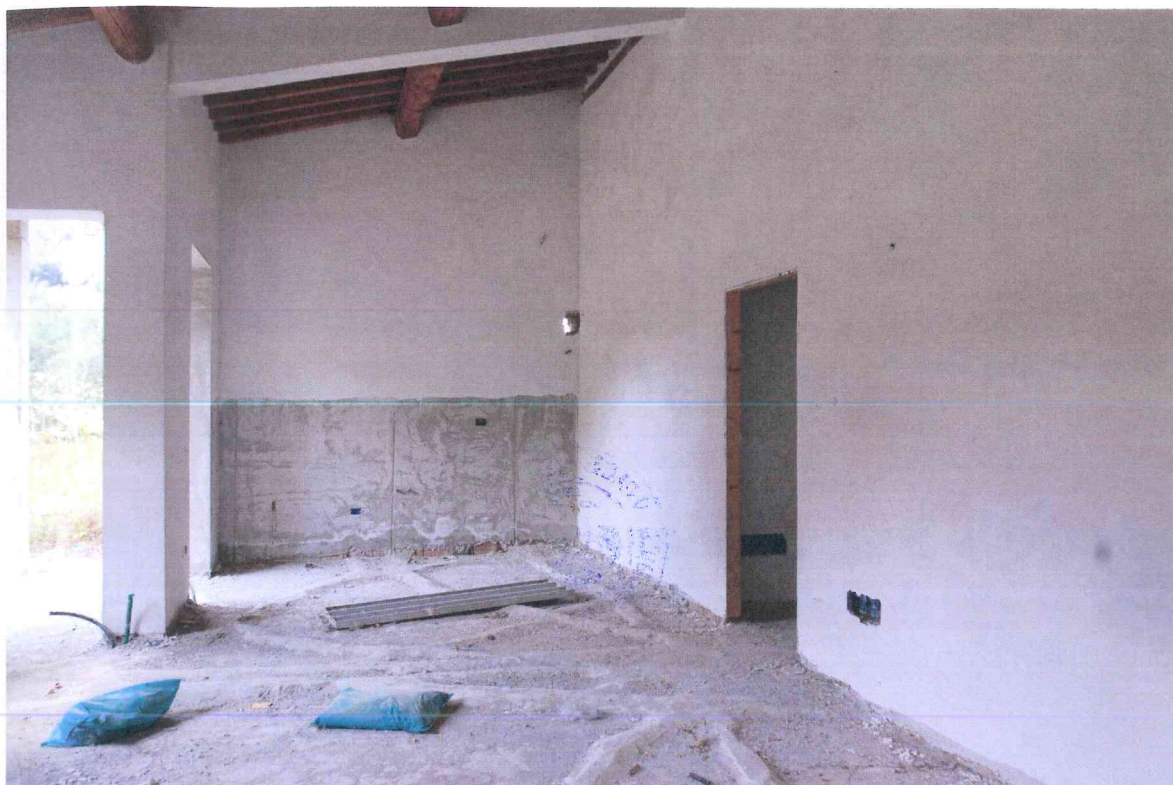
Foto n. 11 Il fabbricato D – interni
