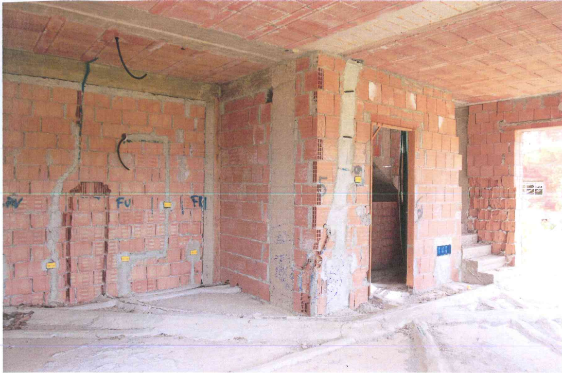
Foto n. 9 Il fabbricato C – interni (lato via Val D'Orlo)
