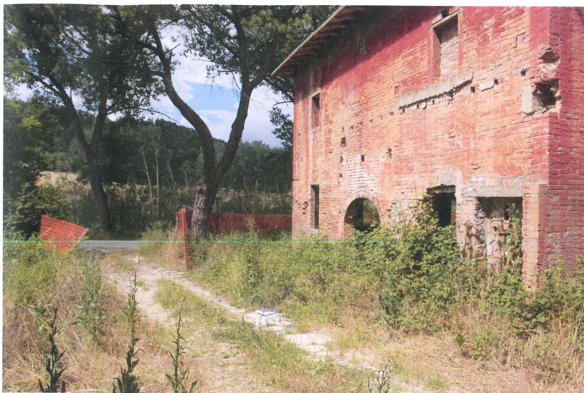
Foto n. 5 Il fabbricato B e l'accesso all'area di cantiere
