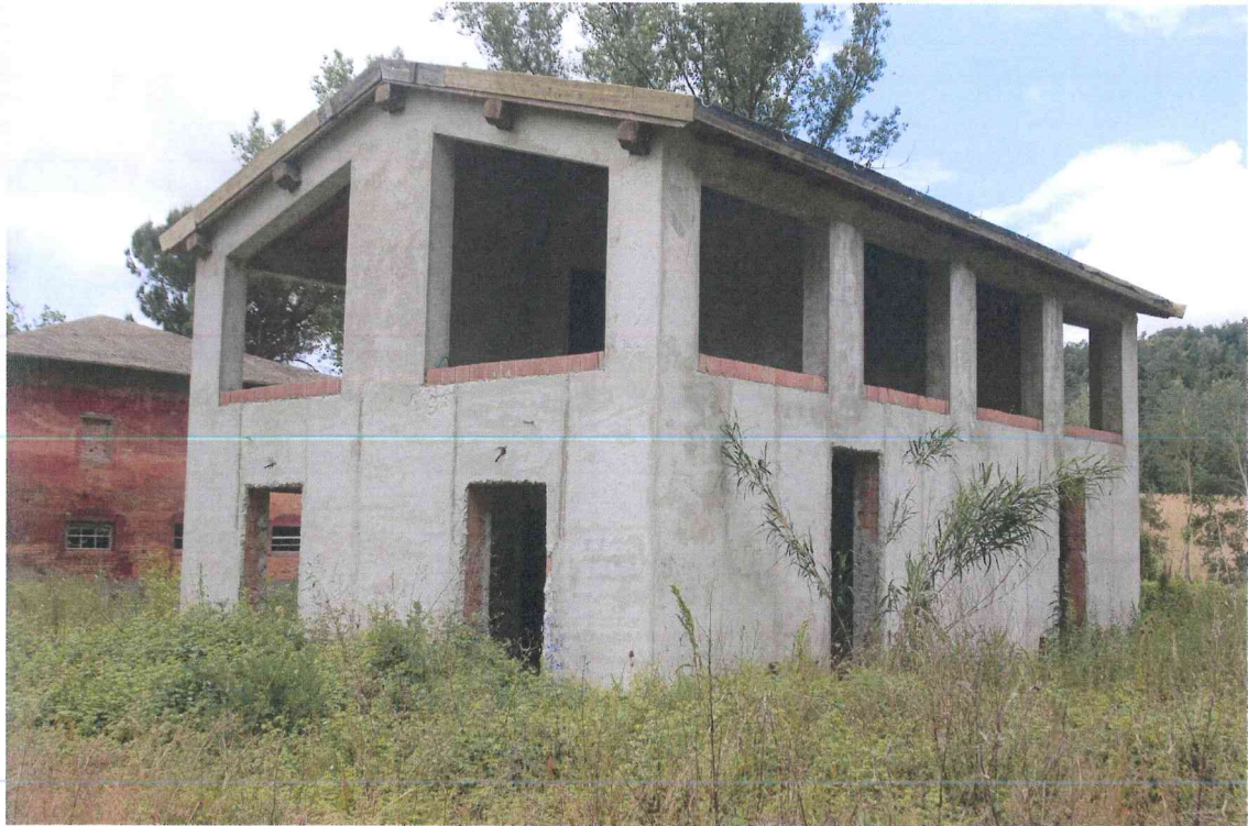
Foto n. 7 Il fabbricato C – prospetto nord-est
