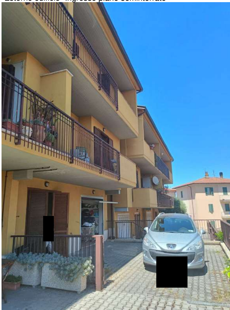
Esterno edificio- Ingresso piano seminterrato
