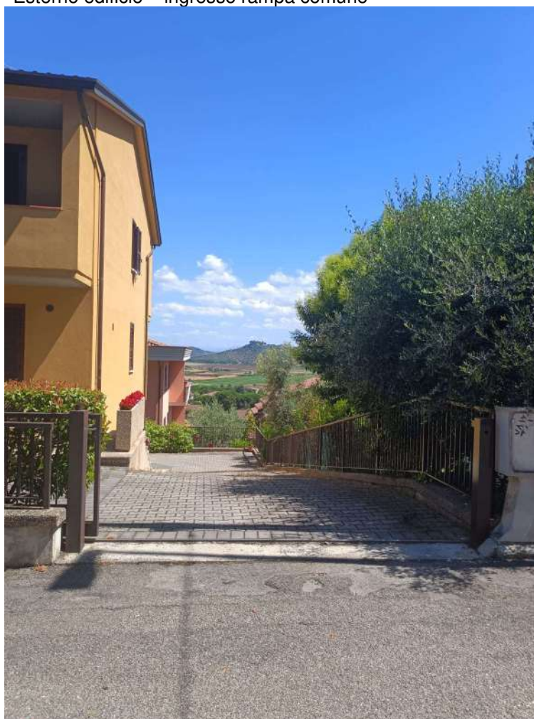
Esterno edificio – ingresso rampa comune
