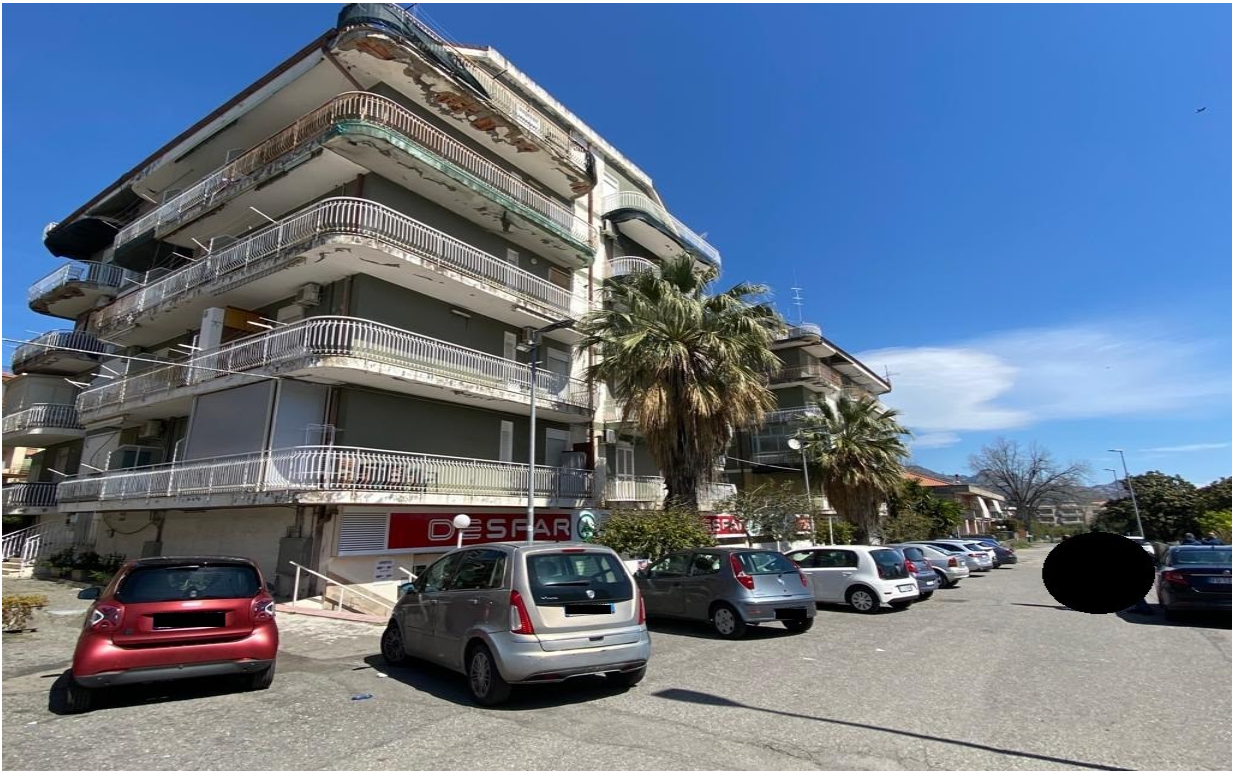
FO 3: prospetto edificio in Via Monteforte Banco; al pian terreno il locale commerciale in esame;
