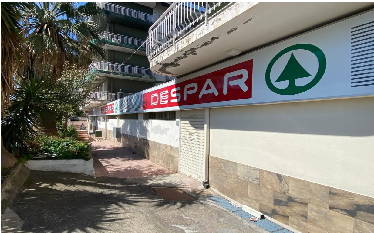
FO 6: esterni locale commerciale;
