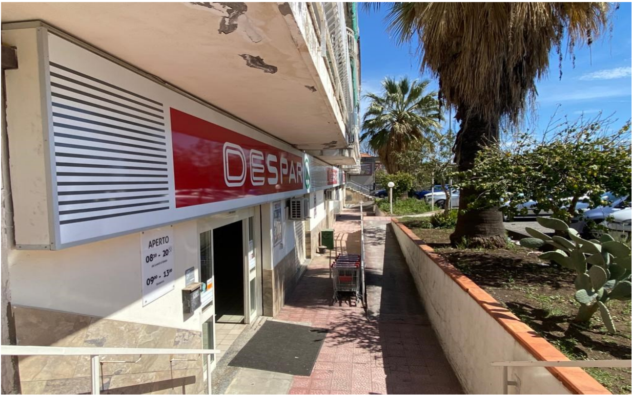
FO 5: esterni locale commerciale in esame;
