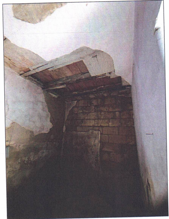
Foto 19-20 - Foto del deposito 2 a cui si accede dal deposito 1. L'ambiente non ha affacci sull'esterno; l'armatura del solaio è deteriorata e vi sono distacchi e crolli di strati di intonaco.
