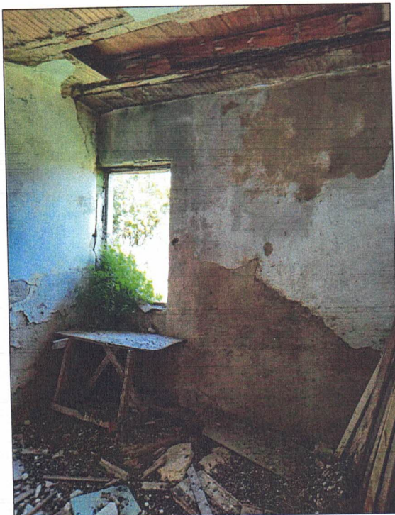
Foto 17-18 - Viste del deposito 1 in pessimo stato conservativo con solai misti e pareti in muratura danneggiati da infiltrazioni di acqua e umidità.
