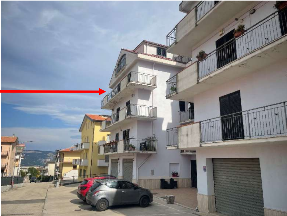
foto n. 1 lato sud-est esterno appartamento terzo piano
