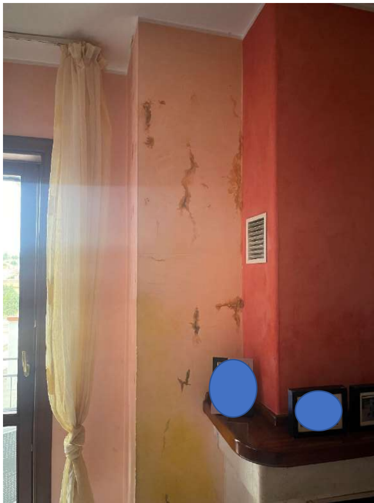
foto n. 5 interno salone – tracce di umidità lato camino
