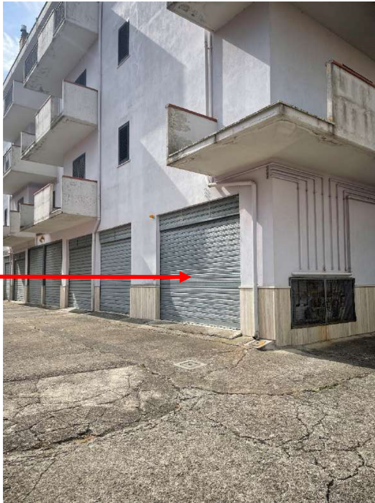
foto n. 3 lato nord ovest esterno deposito
