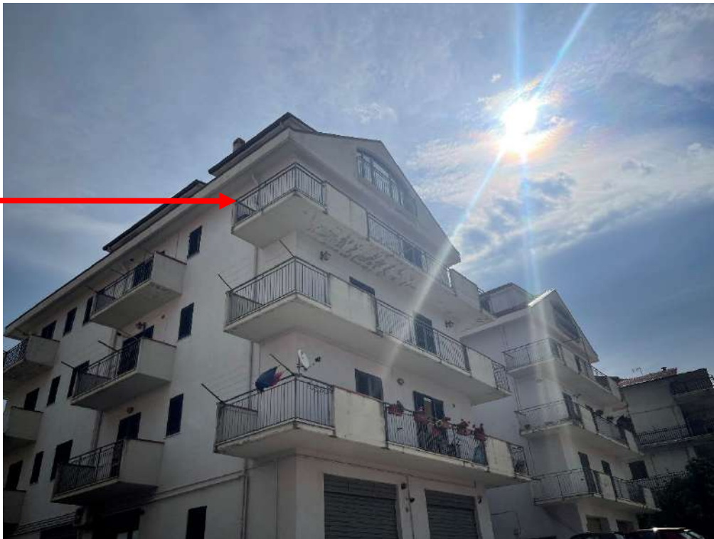
foto n. 2 lato sud ovest esterno appartamento terzo piano
