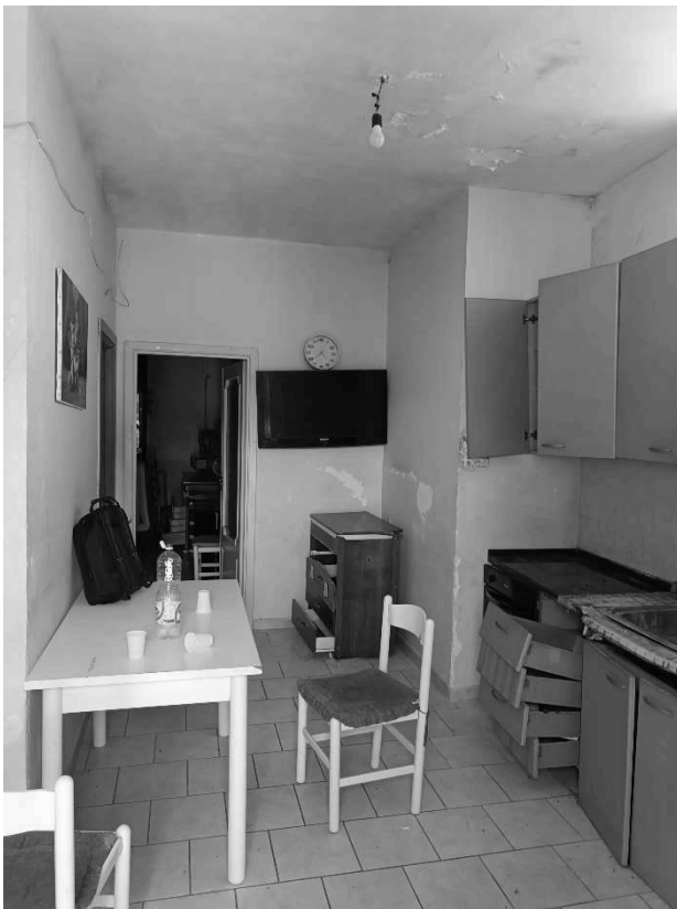
Foto 3. Foto 4. Zona ingresso cucina
