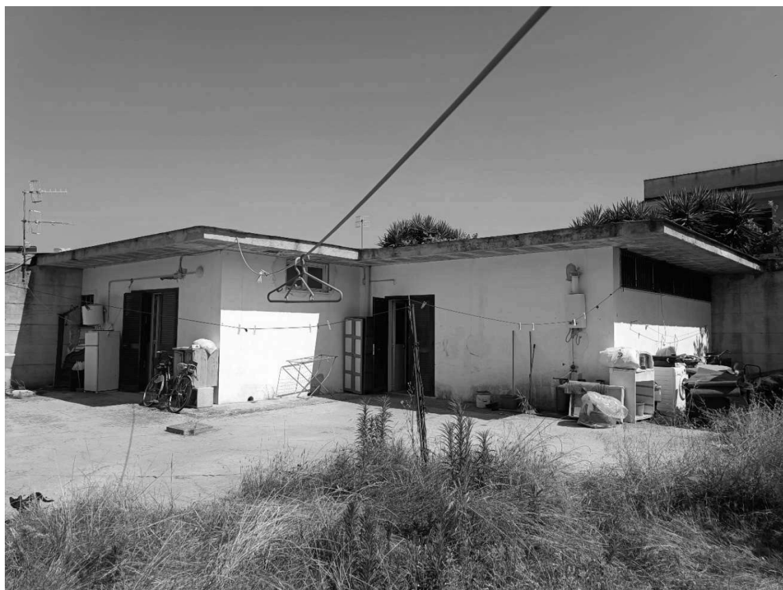
Foto 6 Esterno unità immobiliare
