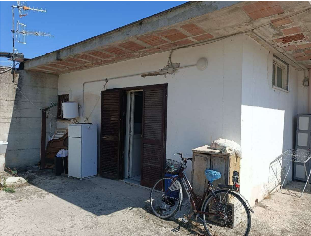
Foto 1. Ingresso prima unità immobiliare
