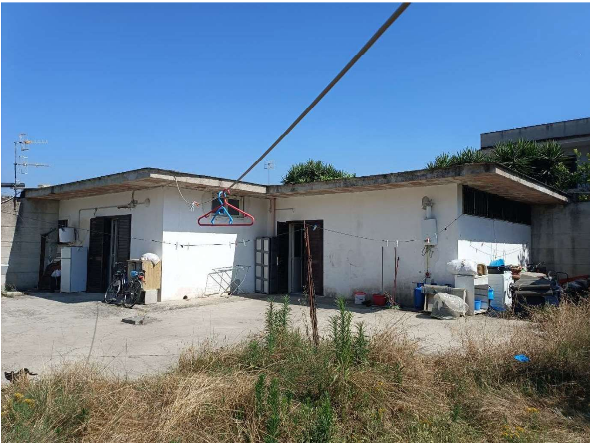
Foto 6 Esterno unità immobiliare
