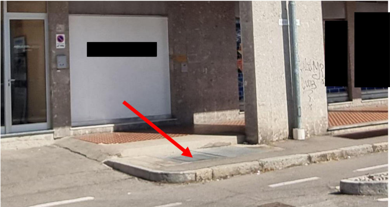
BOTOLA CABINA ENEL
