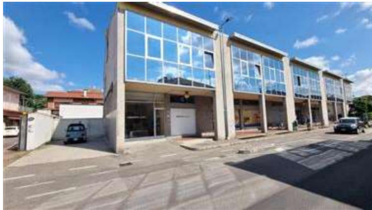
facciata principale edificio
