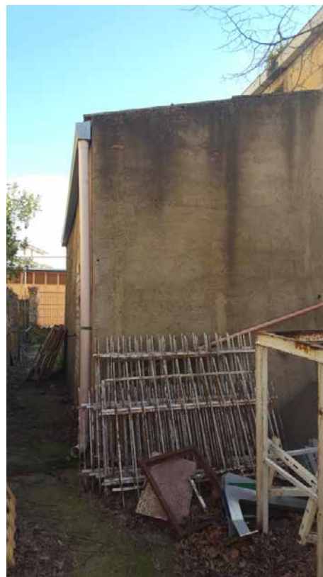
Foto N. 12: Locale Idrico da demolire Lotto L4
