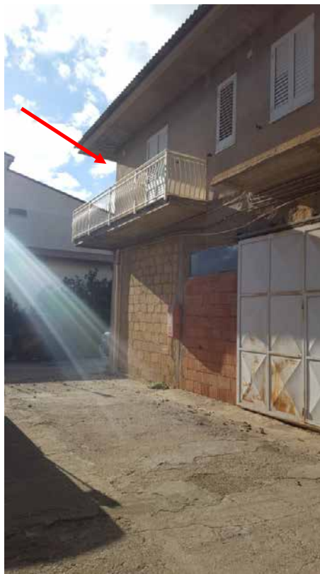
Foto N. 7: Vista Posteriore dalla Corte Comune Lotto L2
