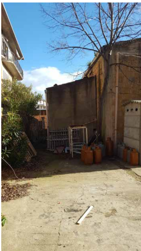
Foto N. 3: Locale Idrico da demolire Lotto L4
