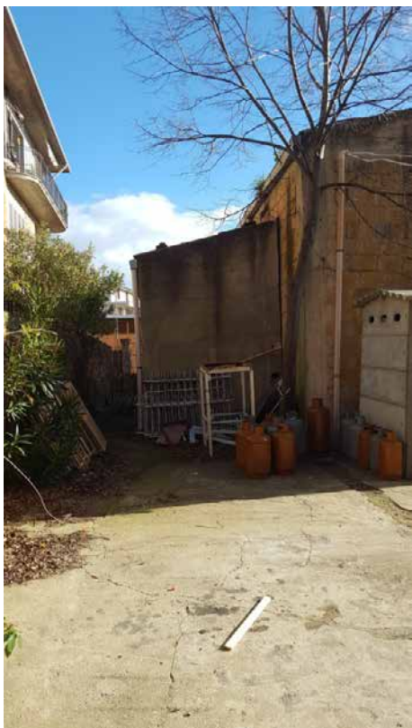
Foto N. 13: Locale Idrico da demolire Lotto L4
