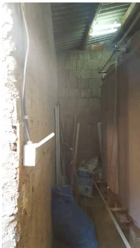
Foto N. 16: Locale idrico da demolire Lotto L4
