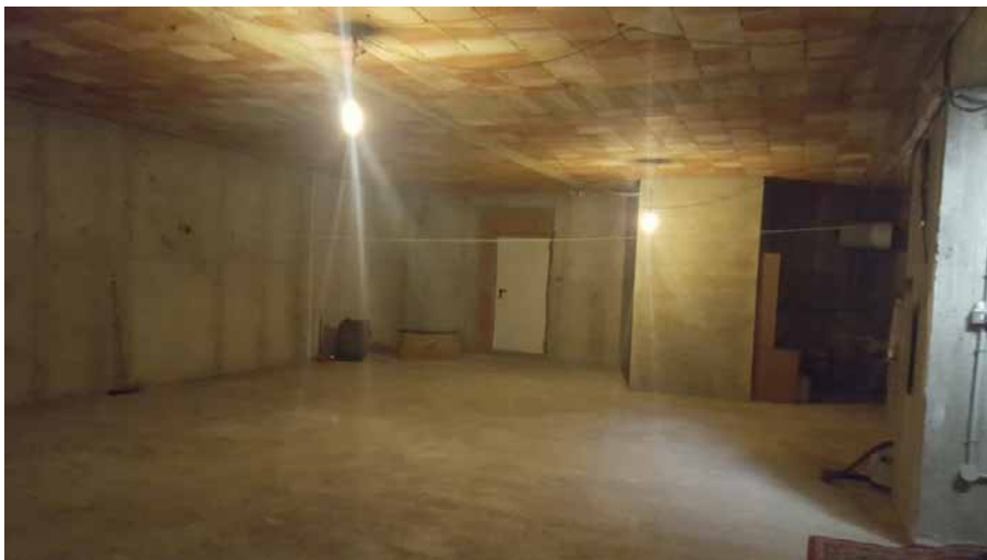
Foto N. 21: Vano n. 2. Piano Primo Lotto L3
