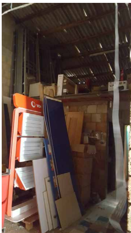
Foto N. 26: Interno del magazzino e controsoffitto Lotto L4
