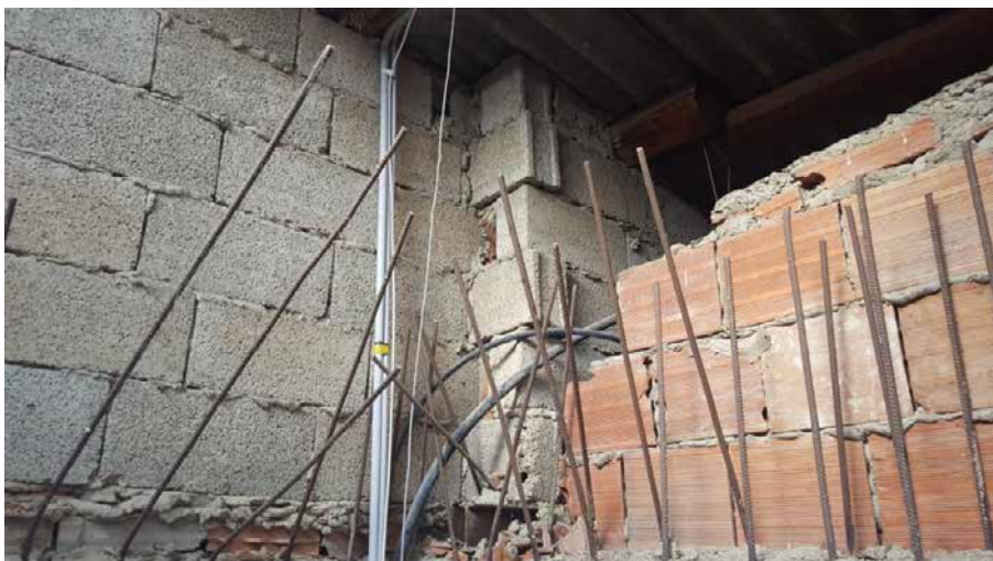
Foto N. 30: Sottotetto. Lotto L3
