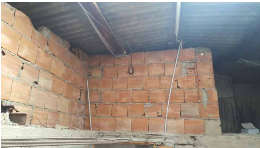
Foto N. 29: Sottotetto. Lotto L3
