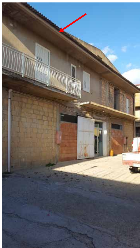
Foto N. 8: Vista Posteriore Dalla Corte comune Lotto L2
