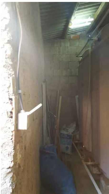
Foto N. 7: Locale idrico da demolire Lotto L4
