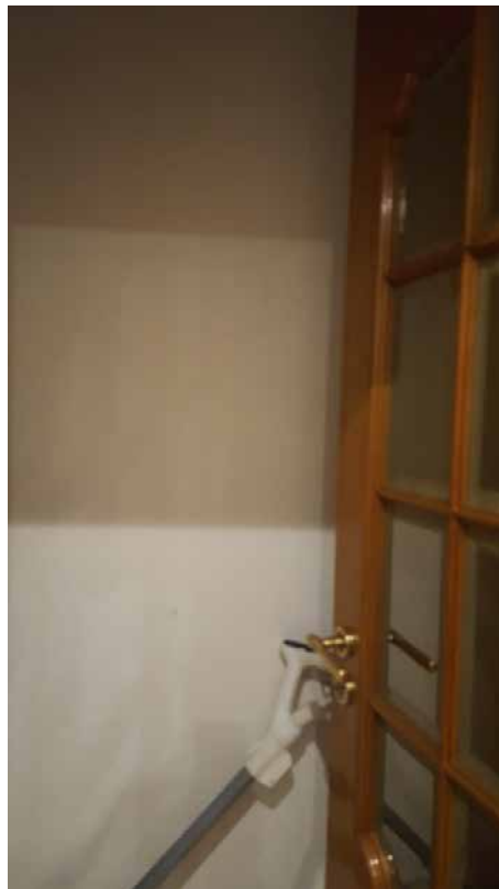
Foto N. 29: finitura della porta del ripostiglio 1 Lotto L2
