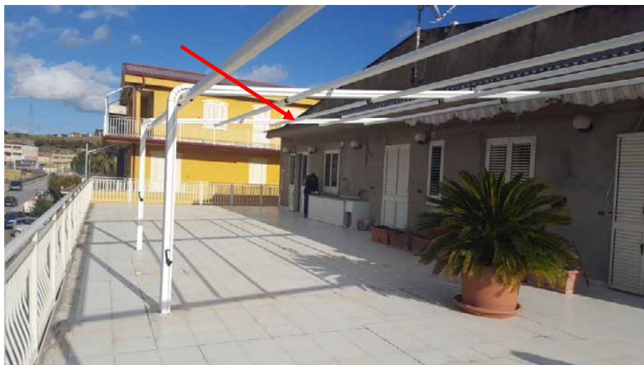
Foto N. 7: Vista Del Terrazzo- Lotto L2-L3
