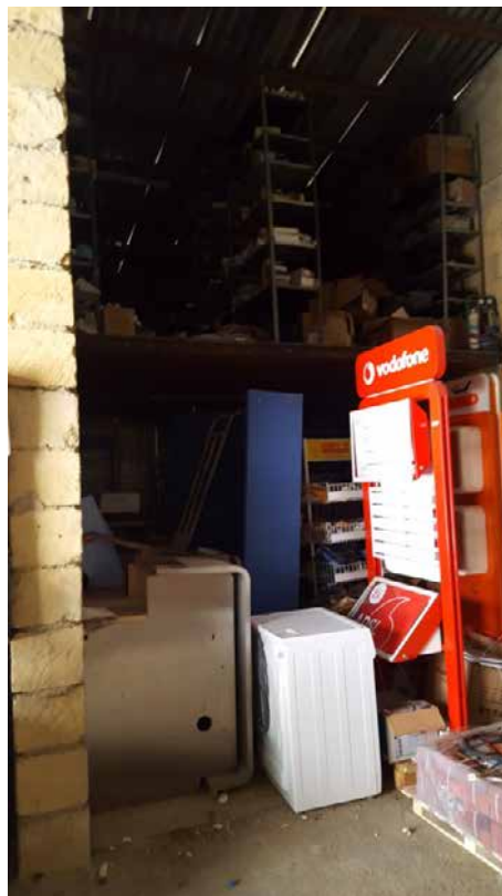
Foto N. 21: Interno del magazzino e controsoffitto Lotto L4
