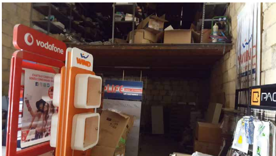
Foto N. 35: Interno del magazzino e controsoffitto Lotto L4
