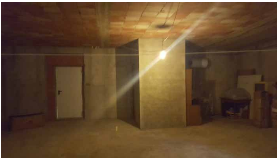
Foto N. 26: Vano n. 2. Piano Primo Lotto L3
