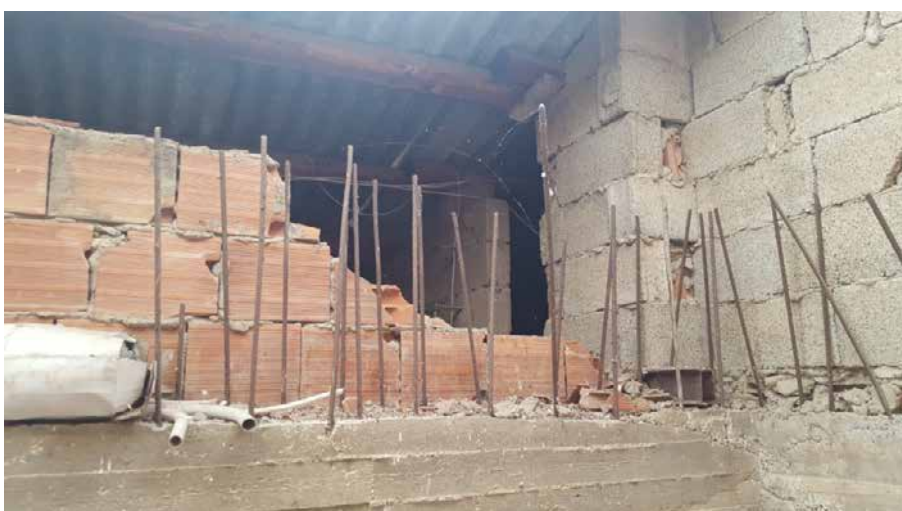
Foto N. 31: Sottotetto. Lotto L3
