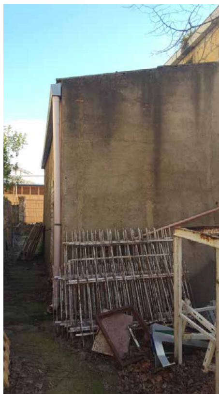
Foto N. 2: Locale Idrico da demolire Lotto L4
