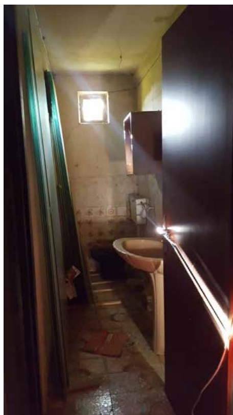
Foto N. 39: Wc del magazzino Lotto L4
