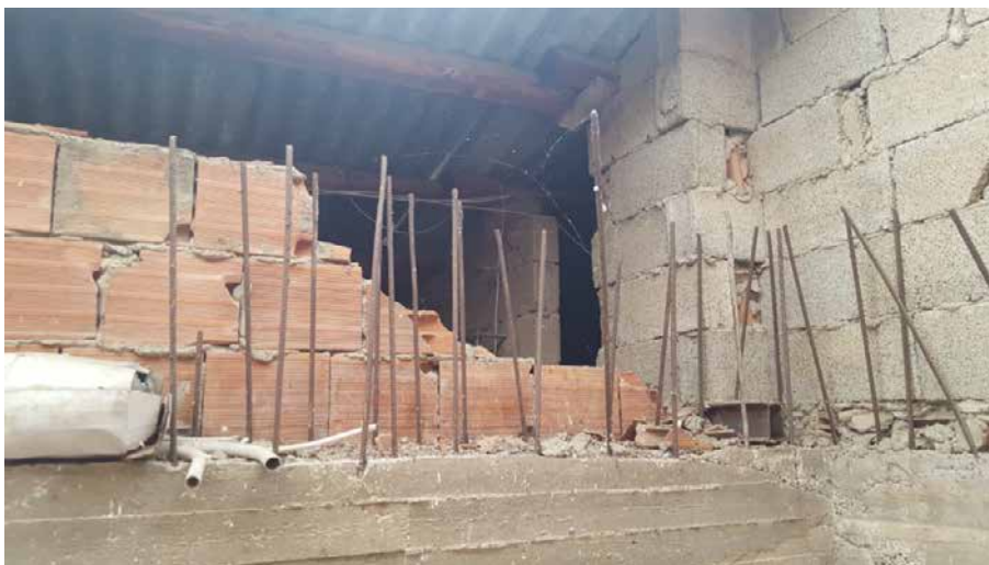
Foto N. 32: Sottotetto. Lotto L3
