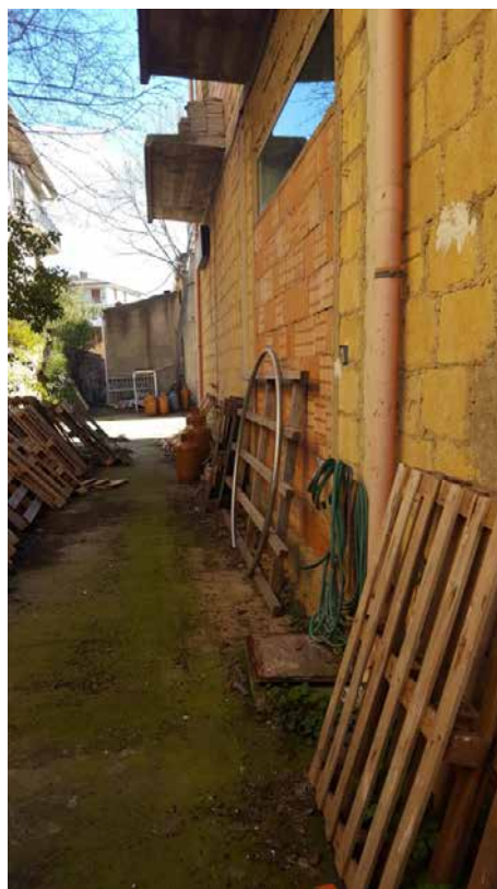
Foto N. 13: Vista laterale sinistra piano terra Lotto L1
