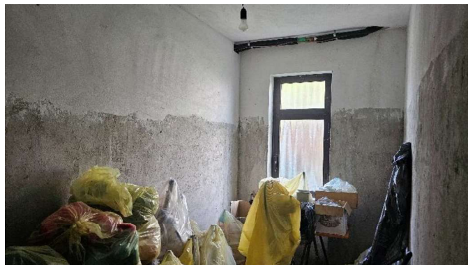
Foto 12 – Cantina (punto A)
