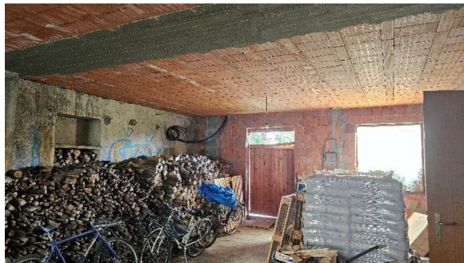
Foto 11 – Cantina (punto A)
