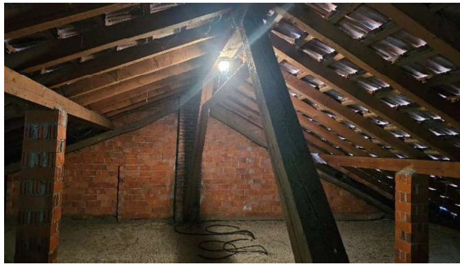
Foto 17 – Sottotetto (punto A)
