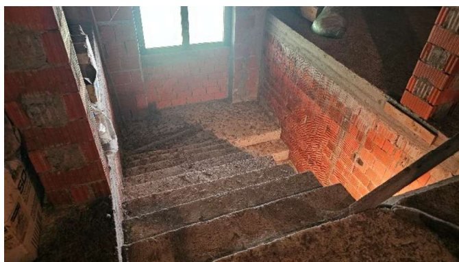
Foto 16 – scala di accesso al sottotetto (punto A)
