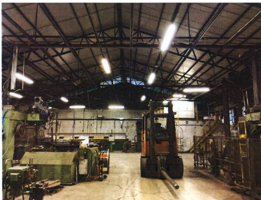
INTERNO CAPANNONE – LATO EST
