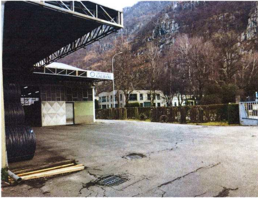
LATO SUD - INGRESSO
