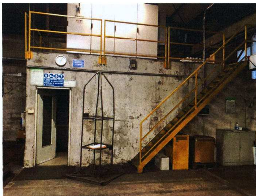
INTERNO CAPANNONE - PARTICOLARE CORPO UFFICIO
