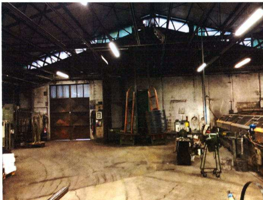
INTERNO CAPANNONE – LATO OVEST
