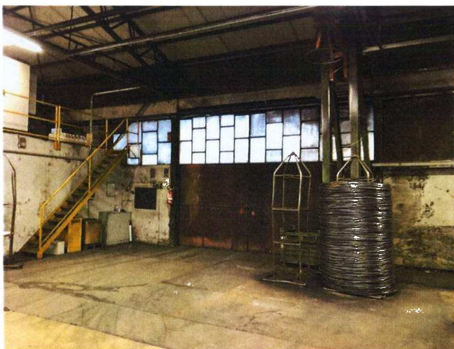
INTERNO CAPANNONE - PARTICOLARE INGRESSO LATO SUD
