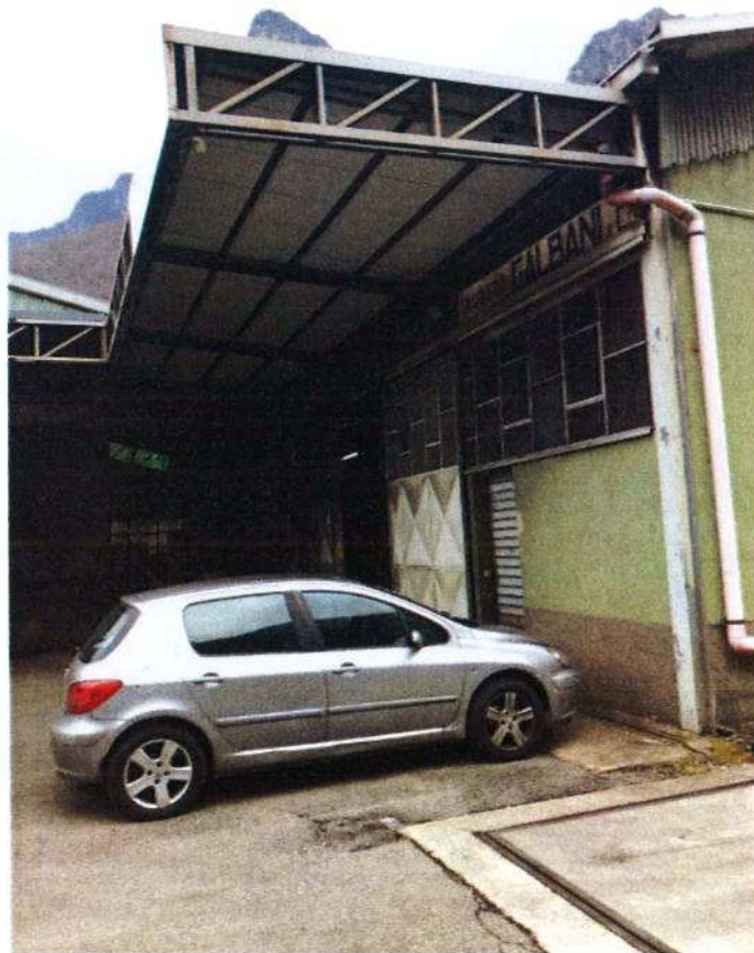
LATO SUD - PARTICOLARE PENSILINA
