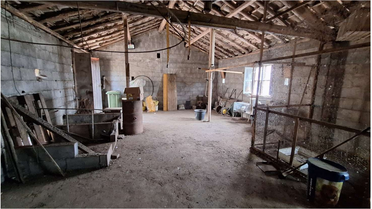
INTERNO PIANO PRIMO IMMOBILE EX CANTINA - DEPOSITO PARTICELLA 589
