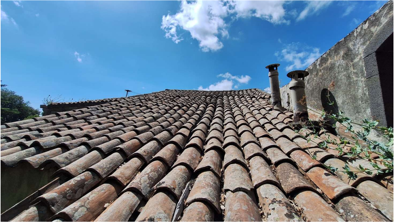
COPERTURA IMMOBILE PRINCIPALE PARTICELLA 679
