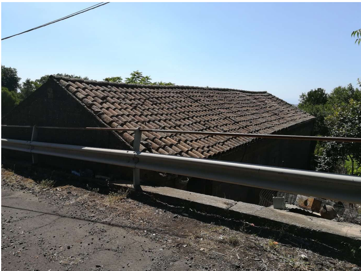
VEDUTA COPERTURA EX CANTINA DAL VIADOTTO
