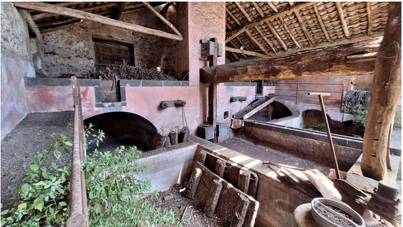
INTERNO IMMOBILE PRINCIPALE PARTICELLA 679
