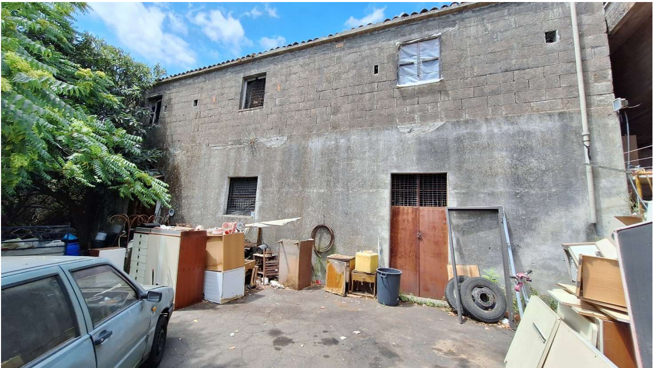
ESTERNO IMMOBILE EX CANTINA – DEPOSITO PARTICELLA 589
