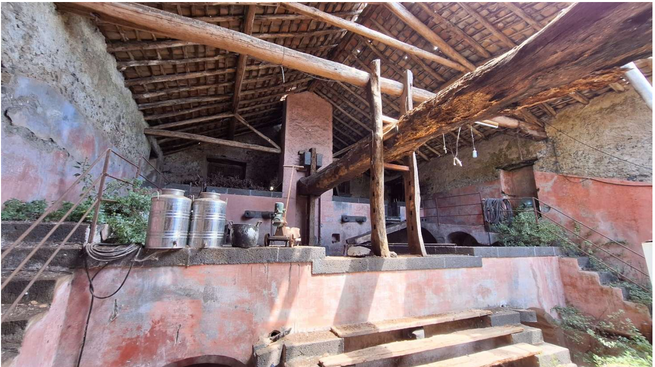
INTERNO IMMOBILE PRINCIPALE PARTICELLA 679
