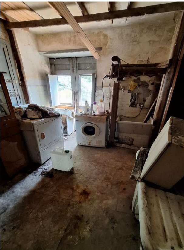
INTERNO IMMOBILE PRINCIPALE PARTICELLA 679
