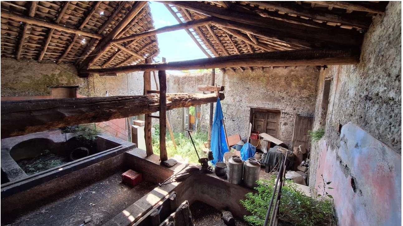
INTERNO IMMOBILE PRINCIPALE PARTICELLA 679
