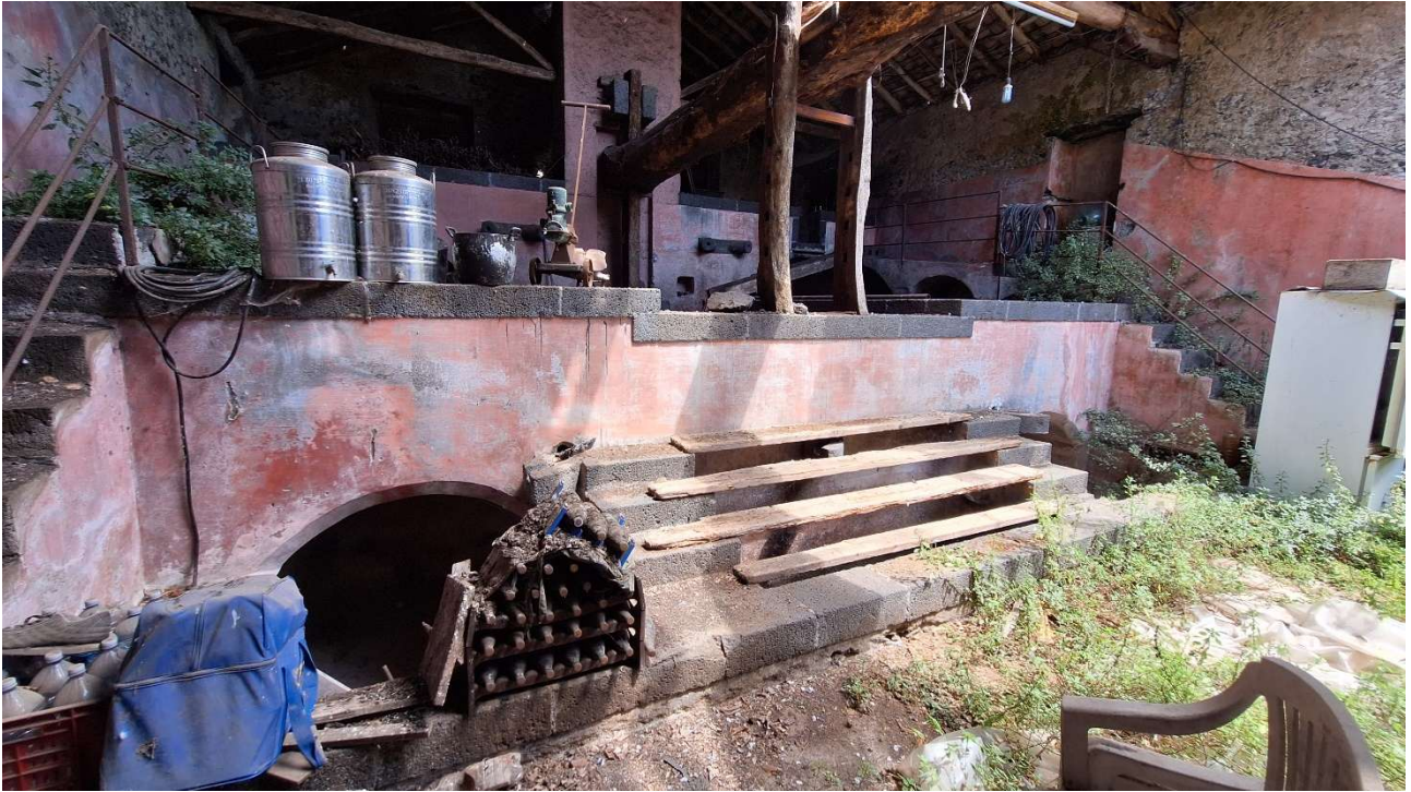
INTERNO IMMOBILE PRINCIPALE PARTICELLA 679
