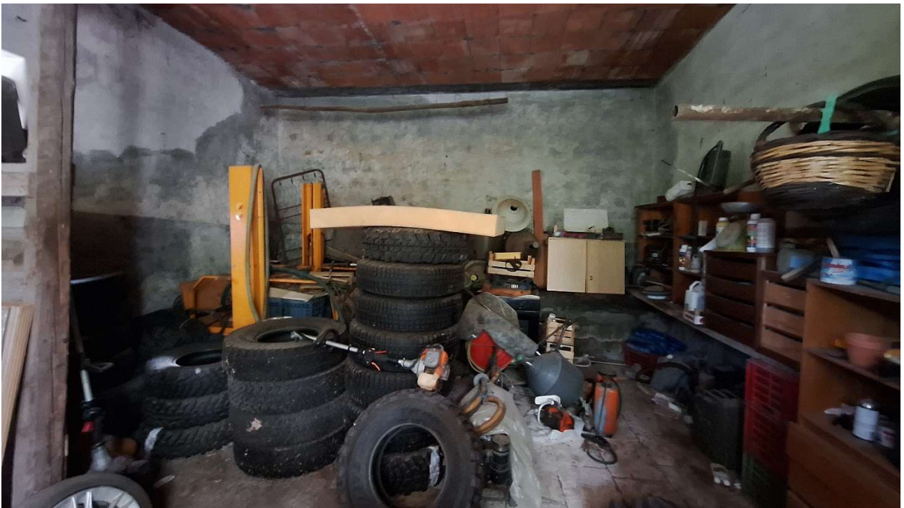
INTERNO PIANO TERRA IMMOBILE EX CANTINA - DEPOSITO PARTICELLA 589
