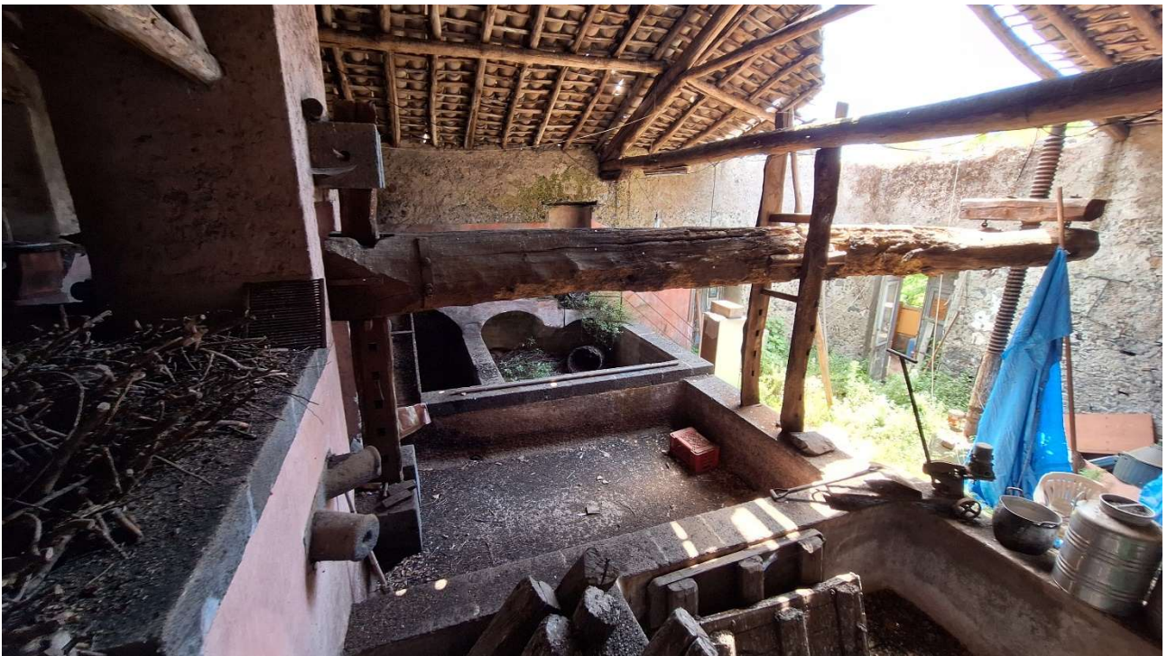
INTERNO IMMOBILE PRINCIPALE PARTICELLA 679
