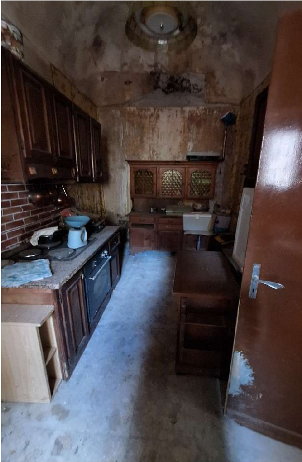
INTERNO IMMOBILE PRINCIPALE PARTICELLA 679
