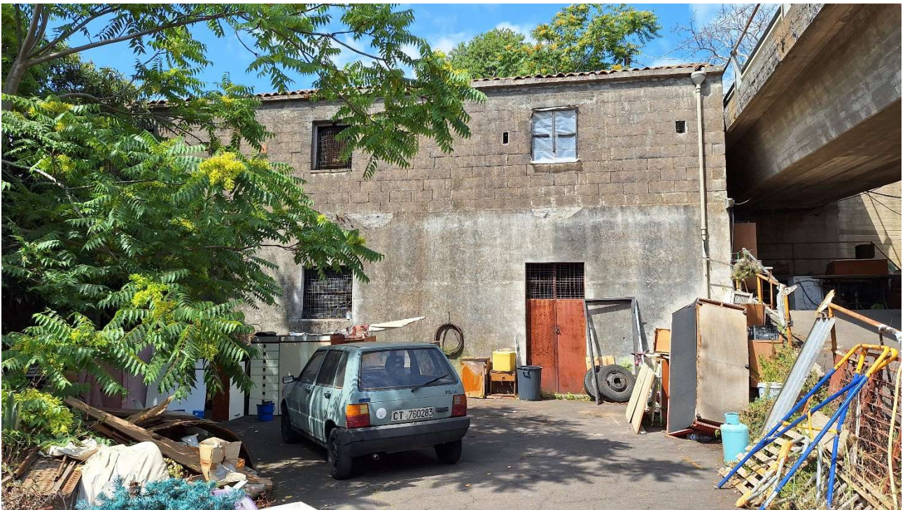
ESTERNO IMMOBILE EX CANTINA – DEPOSITO PARTICELLA 589
