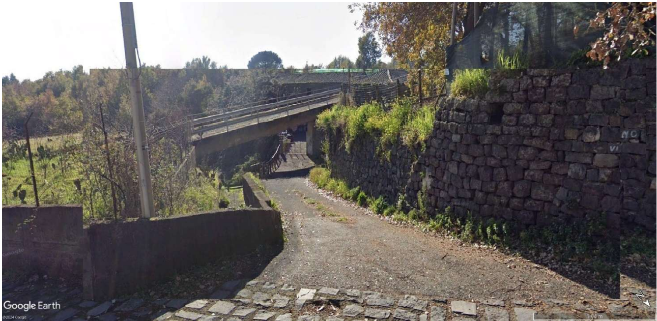
INGRESSO AL CORPO DI FABBRICA EX CANTINA DALLA STRADELLA COMUNE CHE SI DIPARTE DAL CIVICO 45 VIA DOTTORE GIUSEPPE ZAPPALA'
