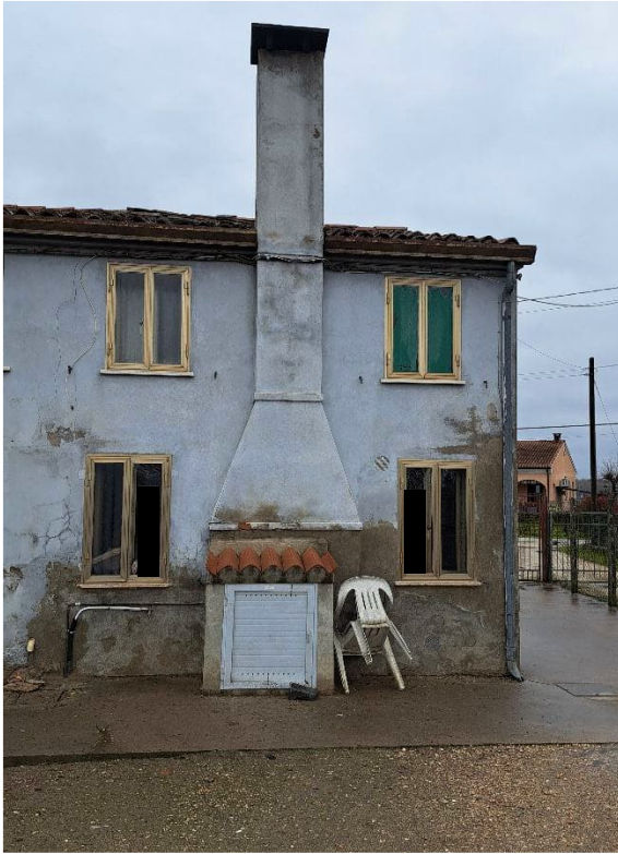
Figura 4: Veduta abitazione lato sud
