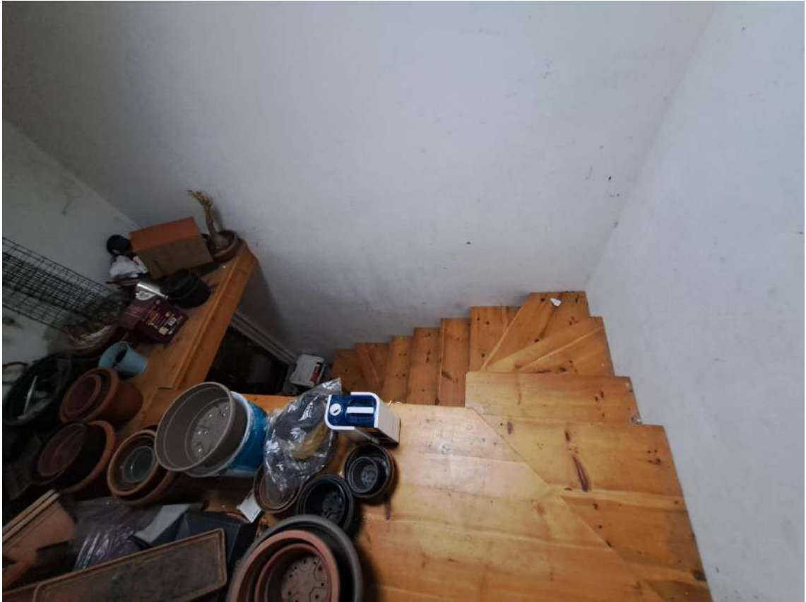
Scala di accesso unità
