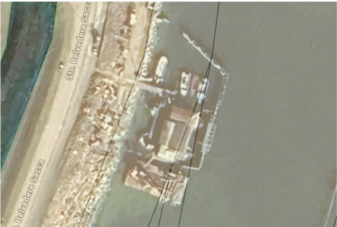
2. particolare immagine satellitare pontile e attrezzature galleggianti
