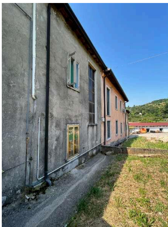
FOTO 3 - prospetto nord abitazione
