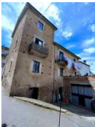
Prospetto Nord – Ingresso magazzino
