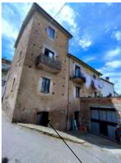
Prospetto Nord — ingresso magazzino
