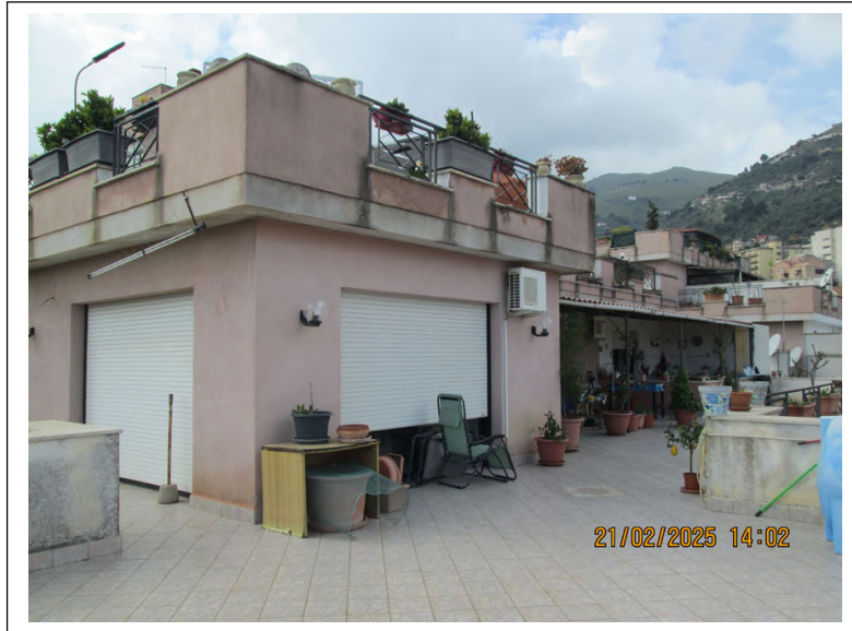
Foto n. 27. Terrazza. Angolo nord-est
