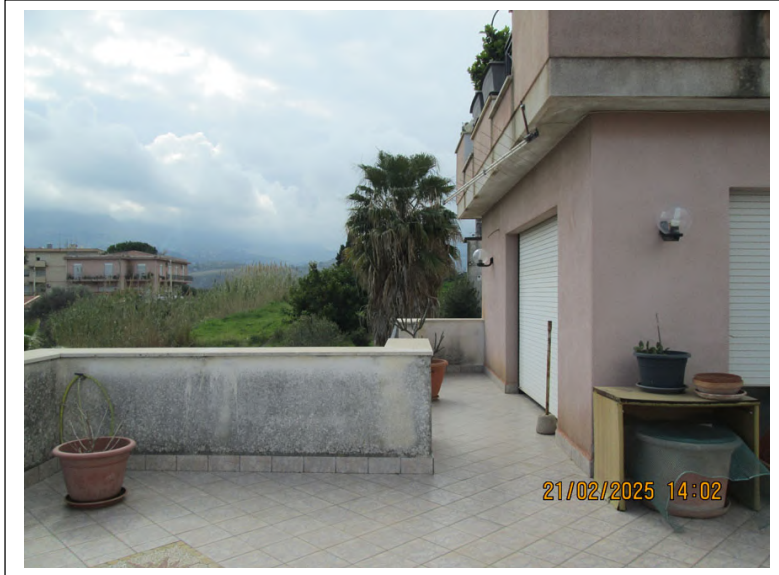
Foto n. 29. Terrazza. Fronte est
