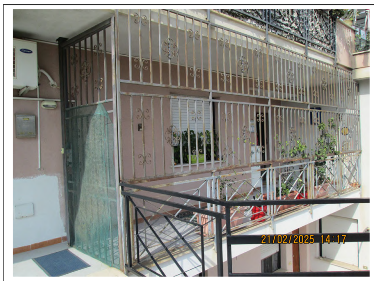
Foto n. 6. Il balcone/ballatoio di ingresso al bene pignorato delimitato da grate metalliche
