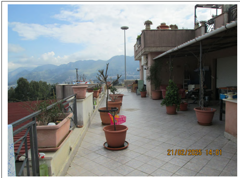
Foto n. 28. Terrazza. Fronte nord
