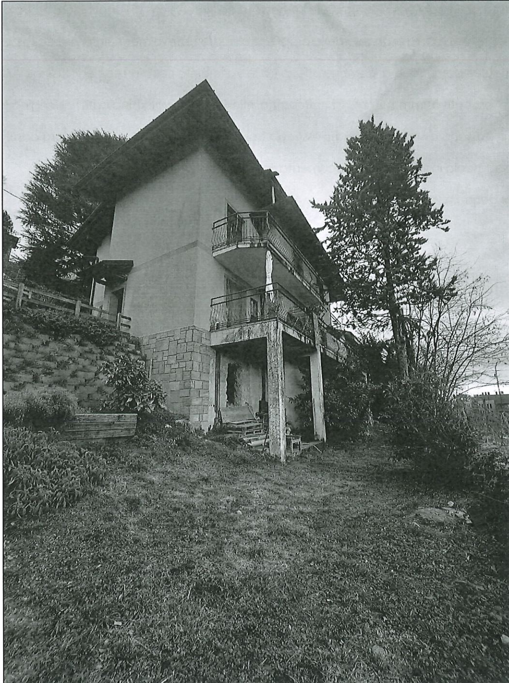
Vista dell'immobile dalla porzione di area interessata dall'occupazione e successiva servitù di sottosuolo
