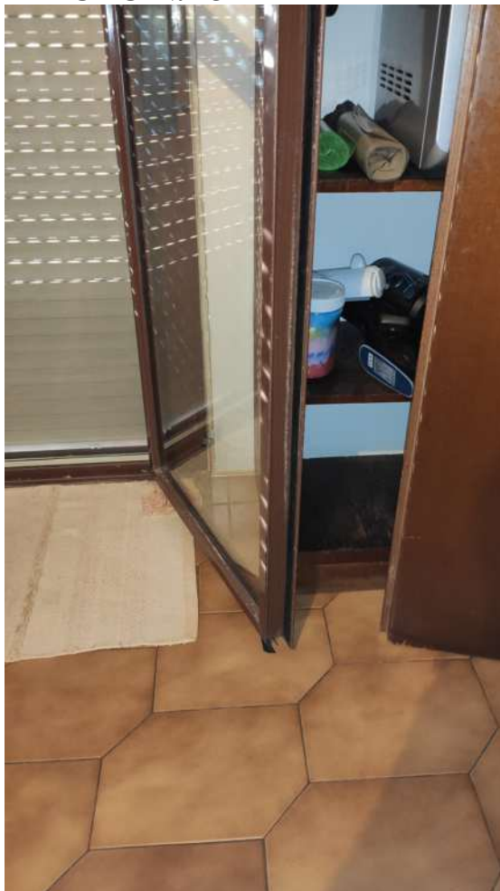
FOTO DALLA N. 23 ALLA N 24: Vista guarnizioni finestre mancanti o deteriorate FOTO N. 23 FOTO N. 24
