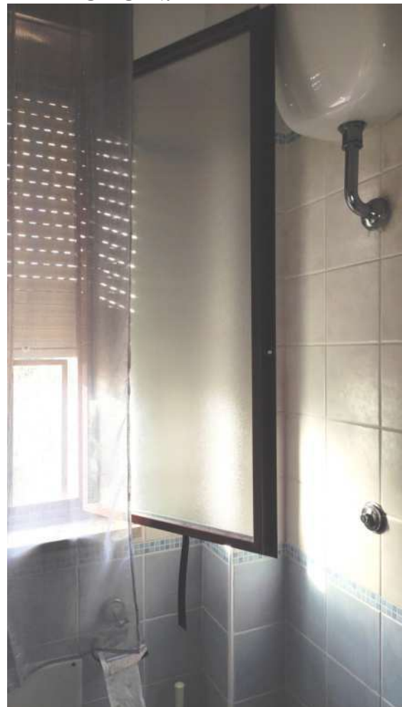
FOTO DALLA N. 23 ALLA N 24: Vista guarnizioni finestre mancanti o deteriorate FOTO N. 23 FOTO N. 24
