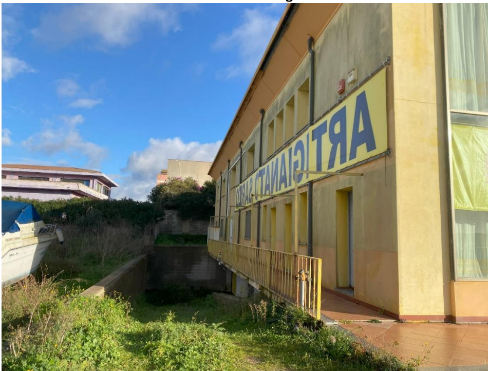
Rampa di accesso autorimessa interrata
