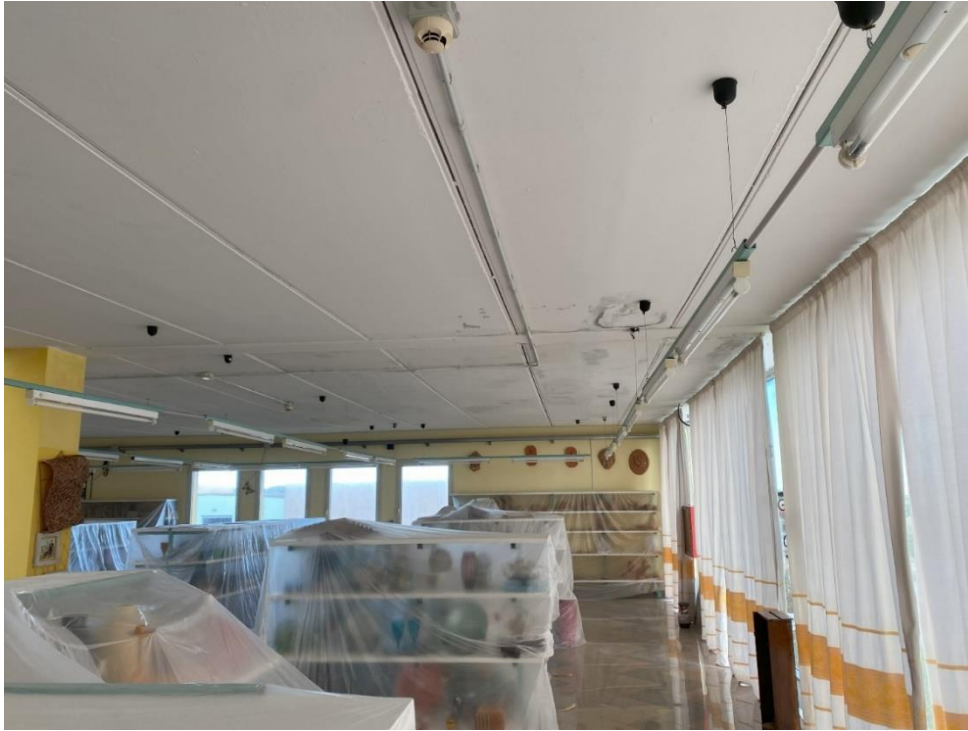
Zona commerciale piano primo
