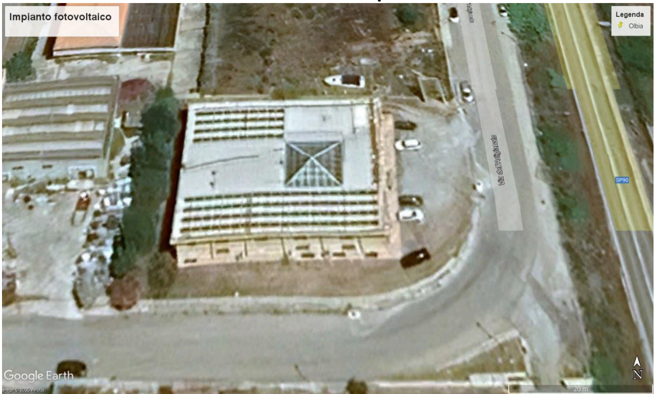
Impianto fotovoltaico 20kw
