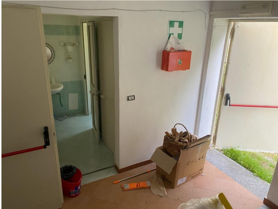
Bagni sub 12 - Accesso vano scale comune a tutti i sub
