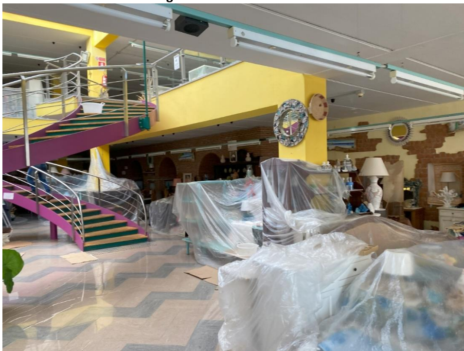
Zona commerciale piano terra
