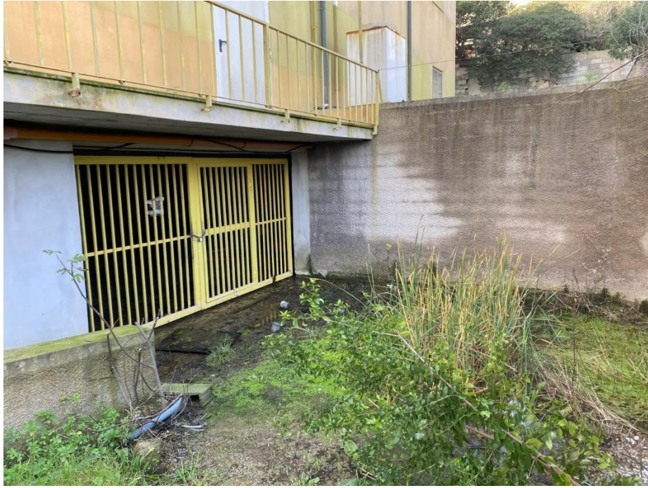
Accesso autorimessa interrata
