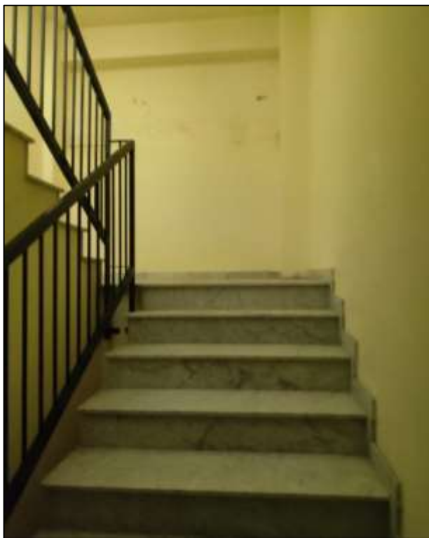
Figura 25 - Vista accesso pedonale al garage dalla scala condominiale del Corpo C.
