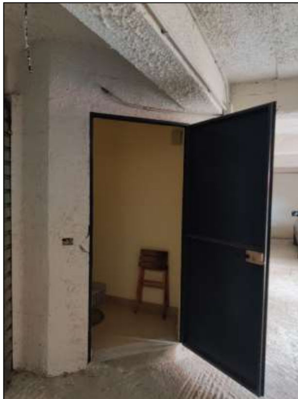
Figura 20 - Vista portone di accesso alla corsia garage dal vano scala condominiale del Corpo C.
