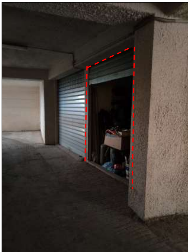
Figura 22 - Vista del garage dalla corsia condominiale.
