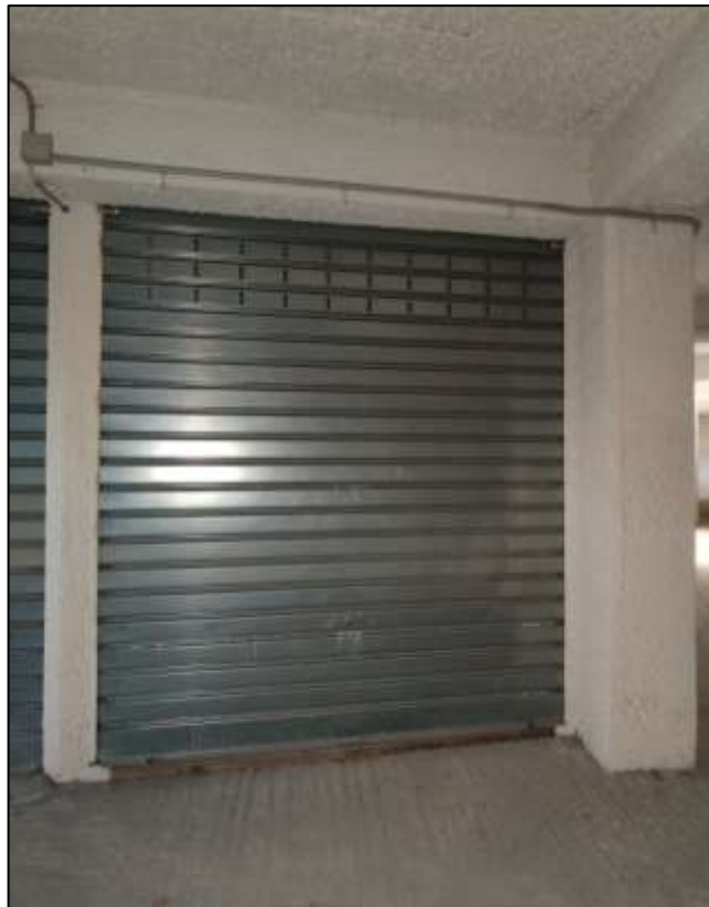
Figura 21 - Vista saracinesca di accesso al garage dalla corsia condominiale.
