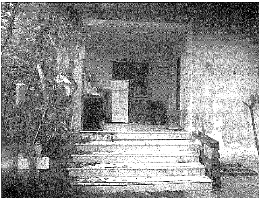
Foto n. 14 <Prospetto SUD con scala di accesso all'unità abitativa - All. N. 3>
