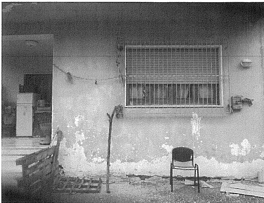
Foto n. 13 <Prospetto SUD - All. N. 3>
