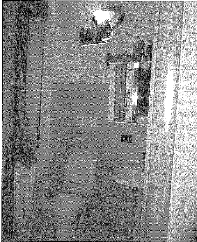
Foto n. 18 <Wc zona giorno adiacente salone d'ingresso - All. N. 3>
