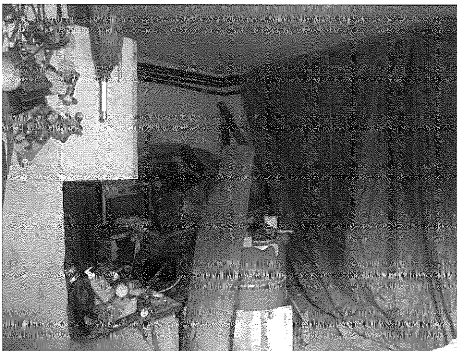
Foto n. 28 <Deposito pertinenze agricole - garage - All. N. 3>
