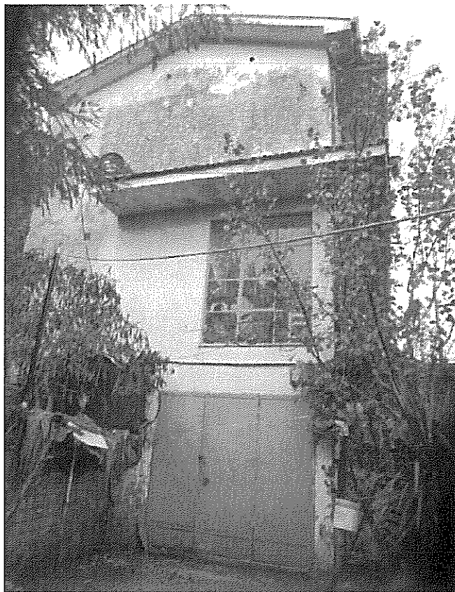
Foto n.10 <Prospetto OVEST – Ingresso piano Seminterrato - All. N. 3>
